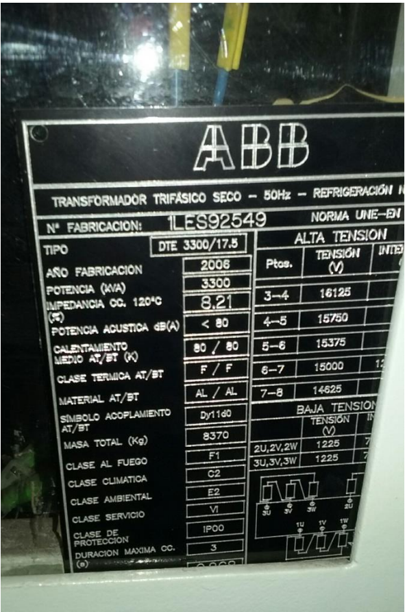
Figura 5: Placa de características de los transformadores del CTR de la Peseta
