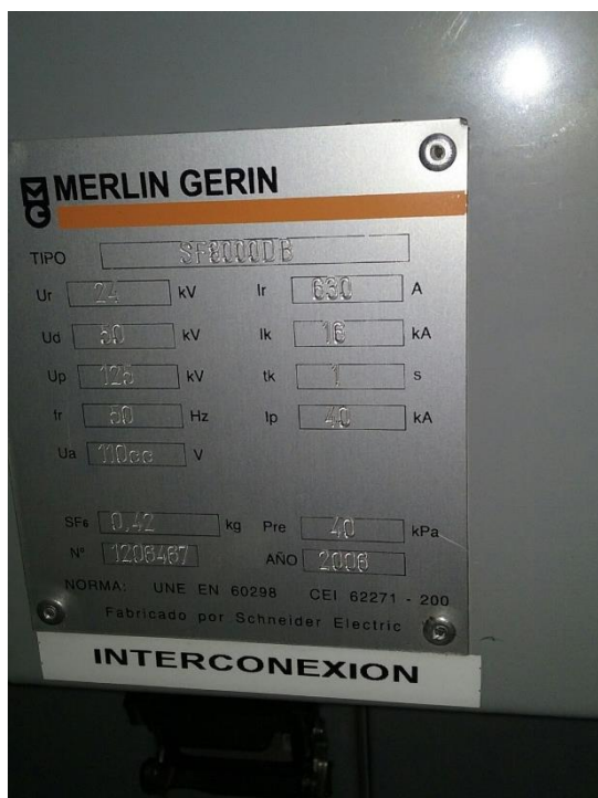
Figura 17: Placa de características de las celdas de corriente alterna del CTR del Barrio del Puerto
