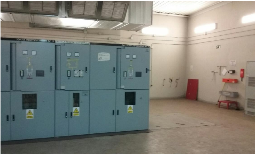
Figura 6: Celdas de corriente continua del CTR de la Peseta
