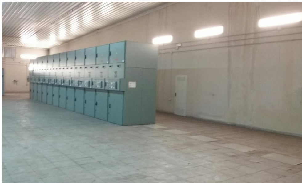
Figura 2: Celdas de corriente alterna del CTR de la Peseta
