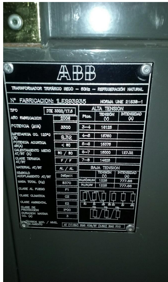
Figura 15: Placa de características de los transformadores del CTR de la Moraleja
