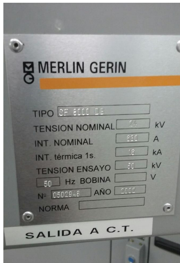
Figura 22: Placa de características de las celdas de corriente alterna del CTR de Hospital de Móstoles
