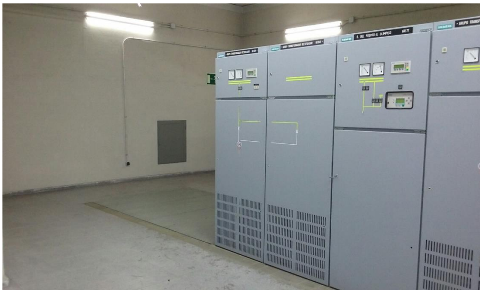
Figura 16: Celdas de corriente continua del CTR del Barrio del Puerto
