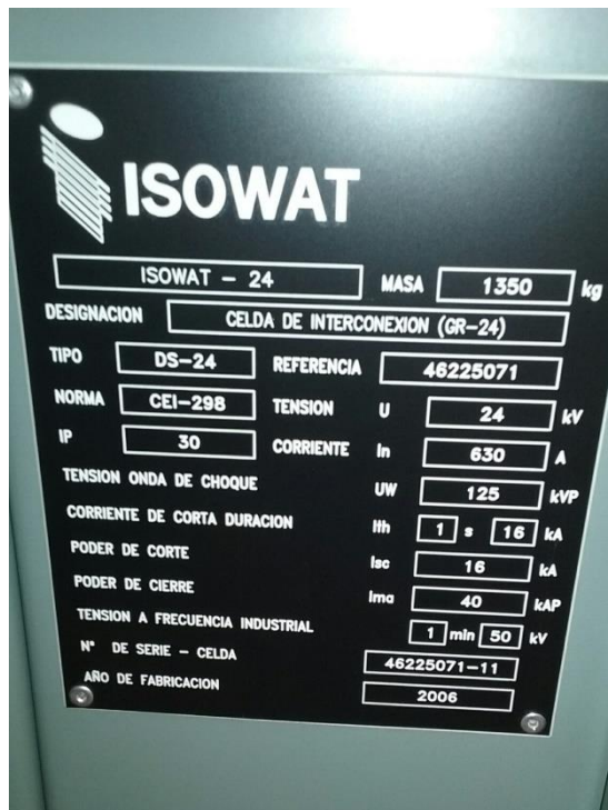
Figura 9: Placa de características de las celdas de corriente alterna del CTR de la Moraleja
