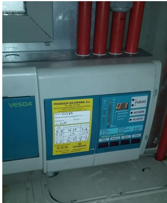
Figura 11: Sistema contraincendios del CTR de la Moraleja
