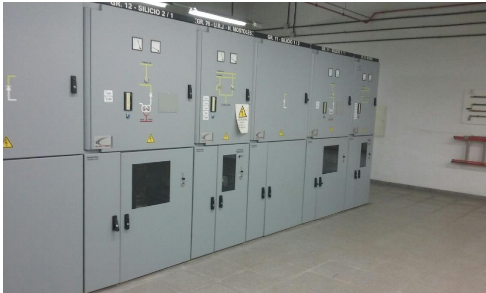
Figura 24: Celdas de corriente continua del CTR de Hospital de Móstoles
