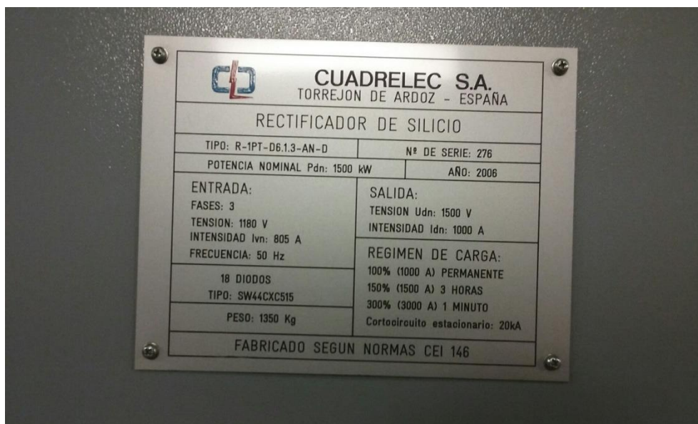
Figura 7: Placa de características del rectificador del CTR de la Peseta
