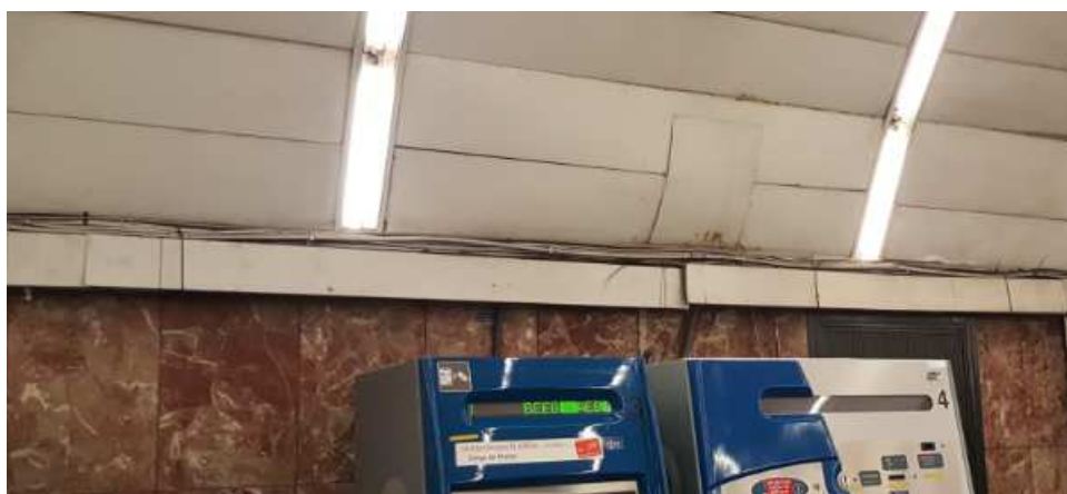
Imagen 1: Ejemplo de bandeja que no puede cerrar y cableado sin canalización
