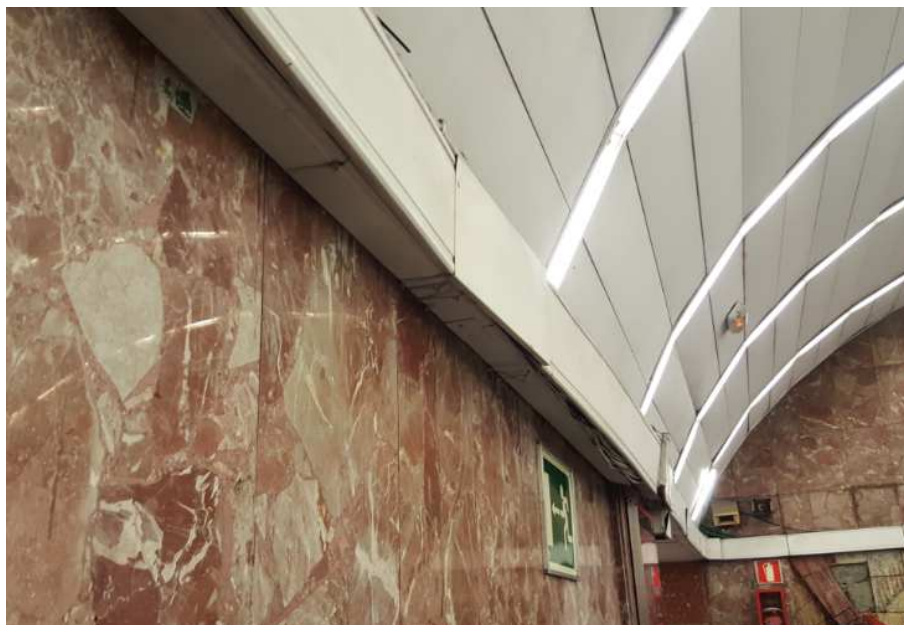
Imagen 4: Bandeja con exceso de cable
