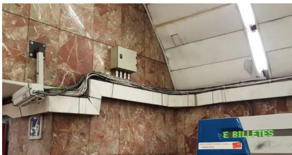
Imagen 4: Zonas con cableado sin conducción
