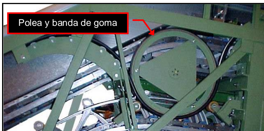
Figura 3. Conjunto sistema tracción pasamanos
