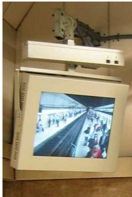
Figura 1: Ejemplo del conjunto de monitor y carcasa instalado en una estación.
