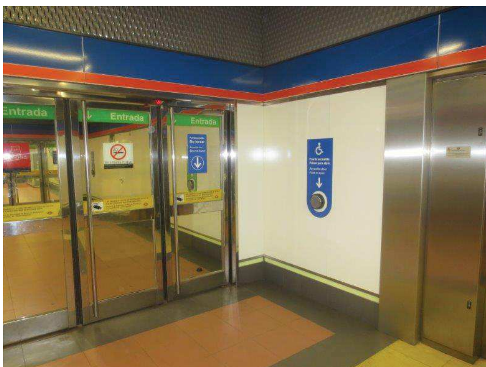
Mamparas cortavientos con medidas de accesibilidad implantadas
