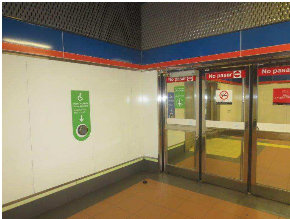
Mamparas cortavientos con medidas de accesibilidad implantadas
