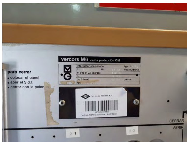
Figura 4: Celda de protección de transformador existente (Nº 2). Centro de reparto
