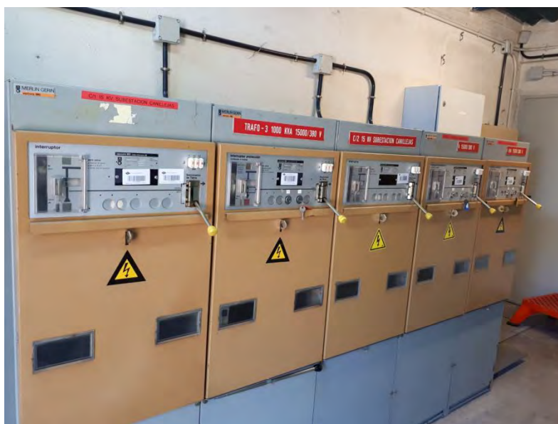
Figura 1: Celdas en Centro de reparto existente
