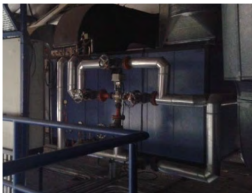
Figura 4: Climatizadores de Nave. TMV-2, 3, 4, 5, 6, 9, 12 y 13.
