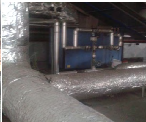
Figura 6: Climatizadores. Zona de baterías y carpintería
