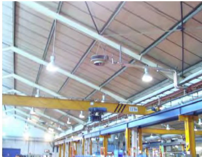
Figura 7: Aerotermos actuales existentes en la nave
