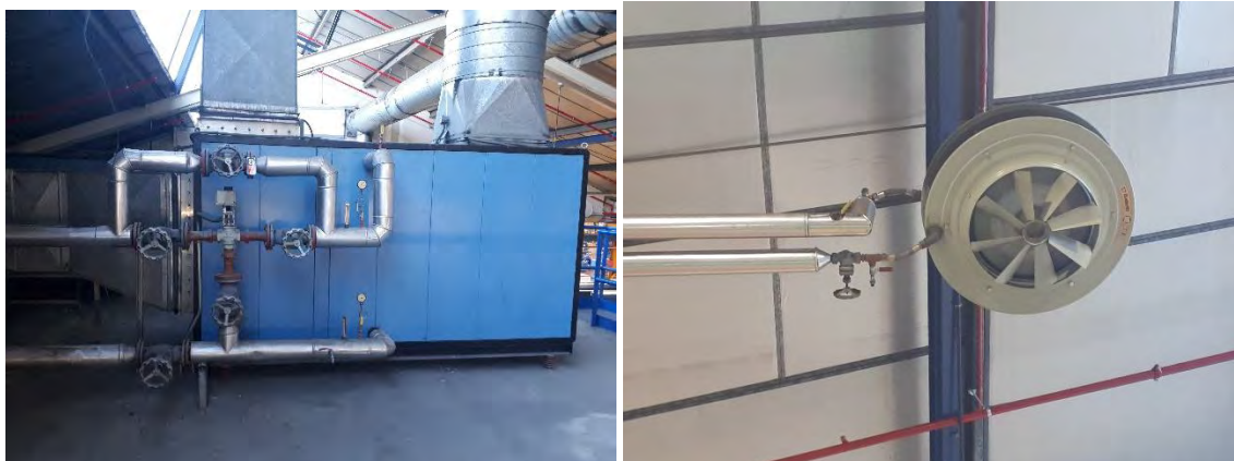
Figura 9: Desmontaje Unidades de Tratamiento de aire y Aerotermos
