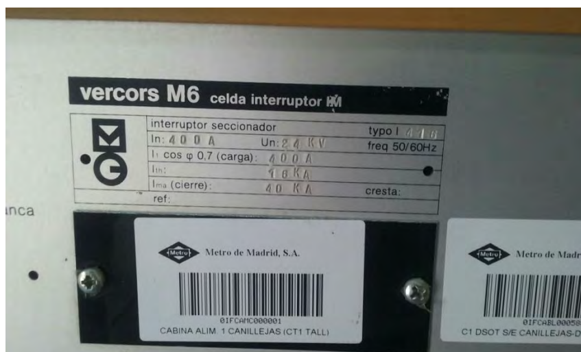
Figura 2: Celda de línea de entrada existente. Centro de reparto
