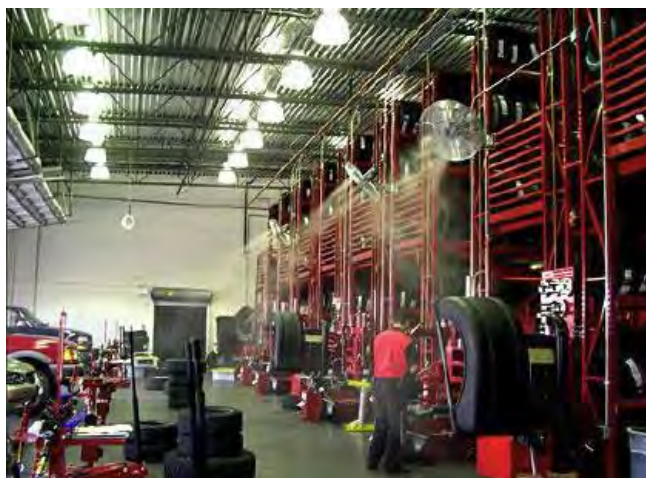
Figura 6: Sistema de climatización mediante agua nebulizada a presión
