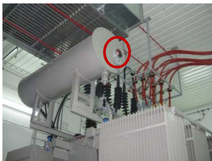
Figura 7. Nivel magnético de aceite
