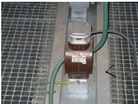
Figura 12. Toroidal protección de cuba
