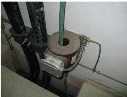
Figura 13. Toroidal protección de neutro
