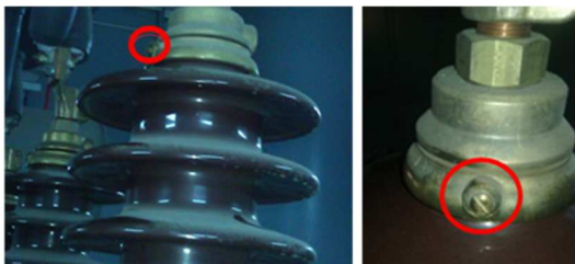
Figura 3. Purga terminales cerámicos AT / BT
