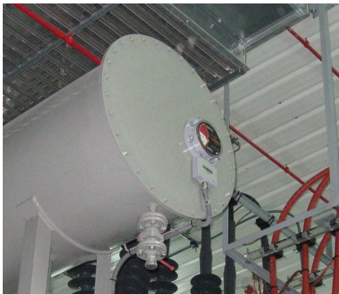
Figura 14. Nivel magnético aceite
