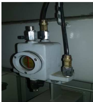
Figura 9. Recuperador / Tomador muestras relé Buchholz
