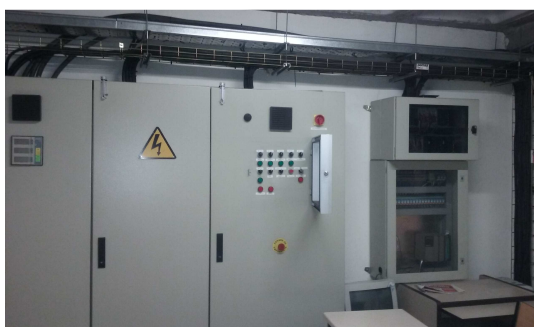
Figura 9: Cuadro eléctrico de fuerza y maniobra del sistema de soplado ubicado en la actual oficina de soplado (cuadro 2 de la figura 7).
