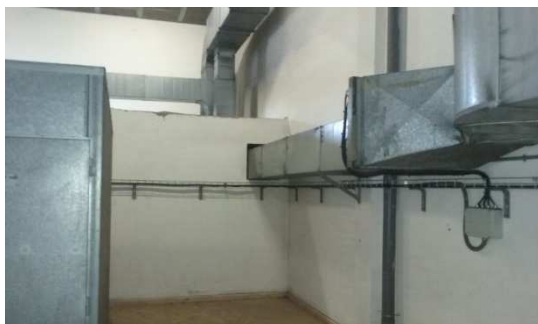
Figura 10: cableado de fuerza y cajas de derivación a desmontar en la zona de conductos (planta 1ª).
