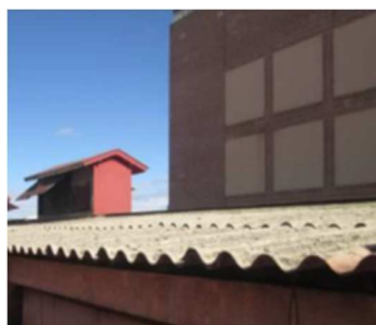
Cubierta de fibrocemento
