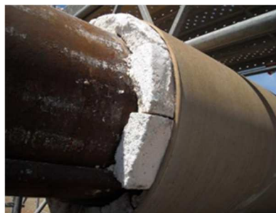
Calorifugado coquilla
