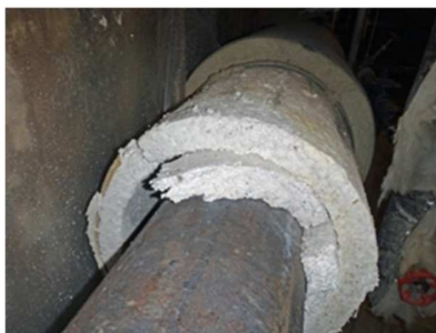
Calorifugado coquilla
