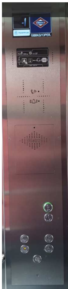
Botonera de cabina instalada en el ascensor de Cuatro Caminos Exterior nº1.
