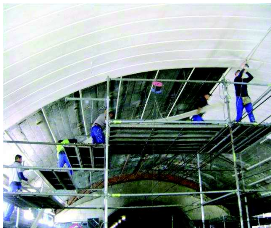
COLOCACIÓN DE FALSO TECHO
