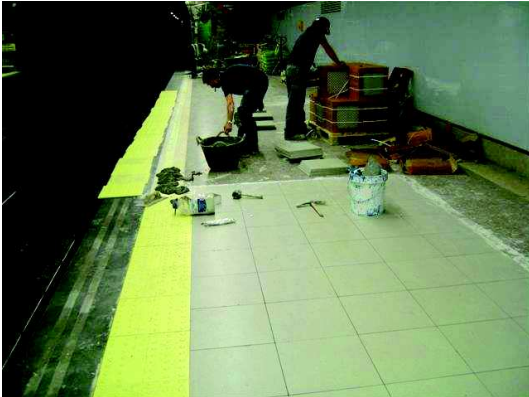
PAVIMENTO PODOTÁCTIL BORDE DE ANDÉN
