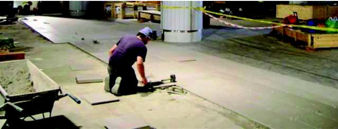
COLOCACIÓN DE SOLADO
