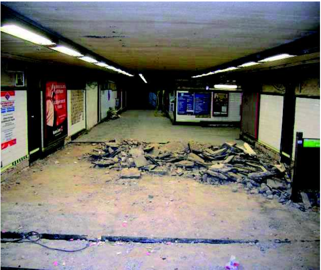
DEMOLICIÓN DE SOLADO
