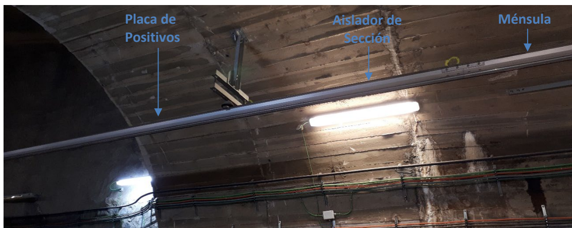
Situación futura de las placas de positivo y aisladores de sección (pk 4+075)
