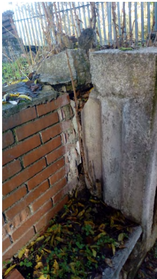
Foto 18 Placa de fibrocemento embebida en el muro de contención
