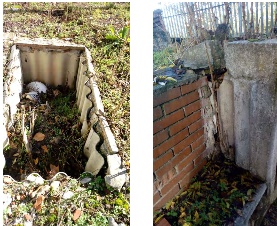
Foto 24 Arqueta y muro de contención con placas de fibrocemento
