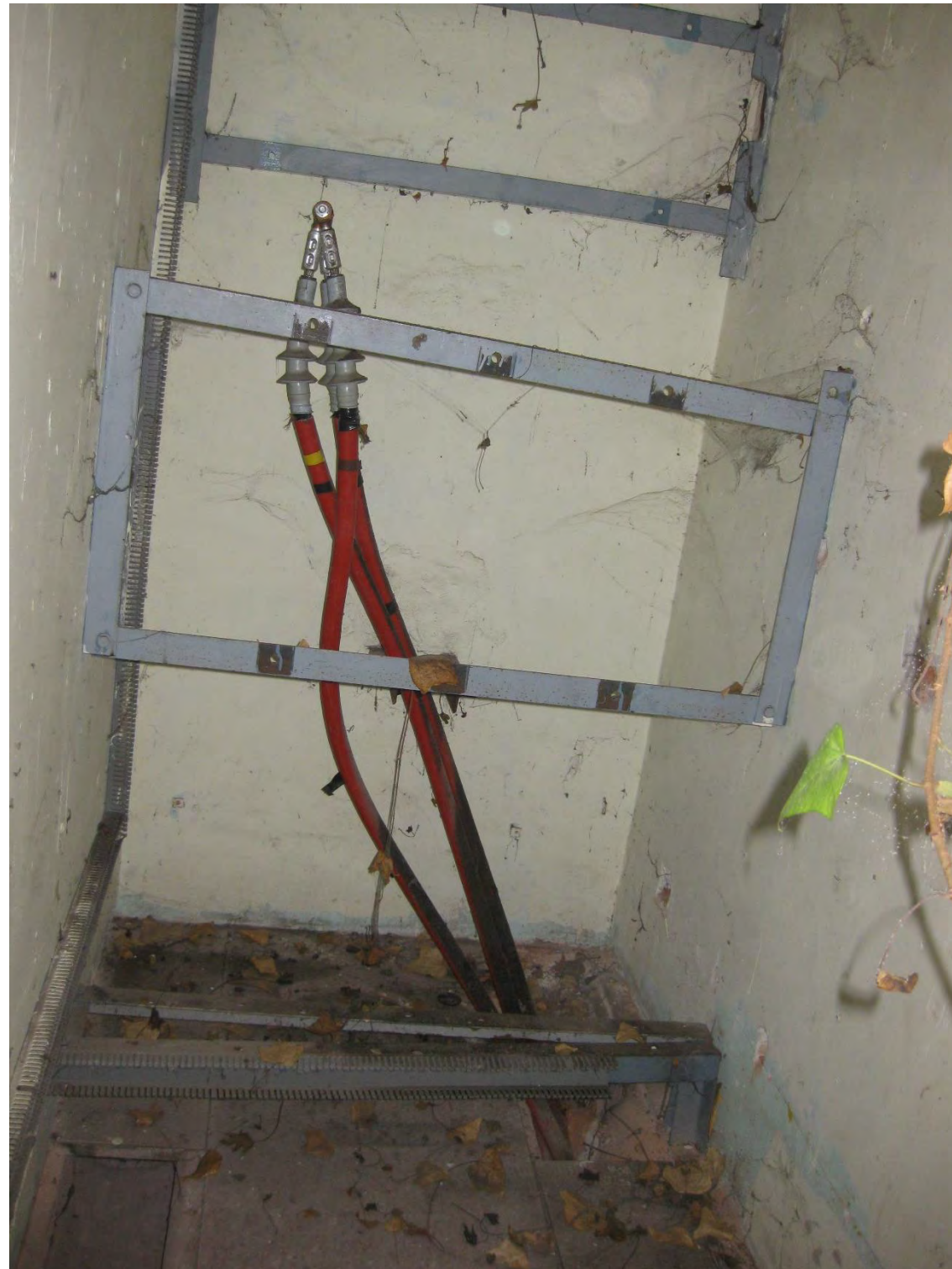
Foto 5 Cableado a retirar
