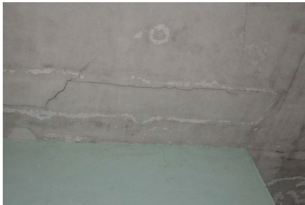
Foto 33 Fisuras en cubierta
