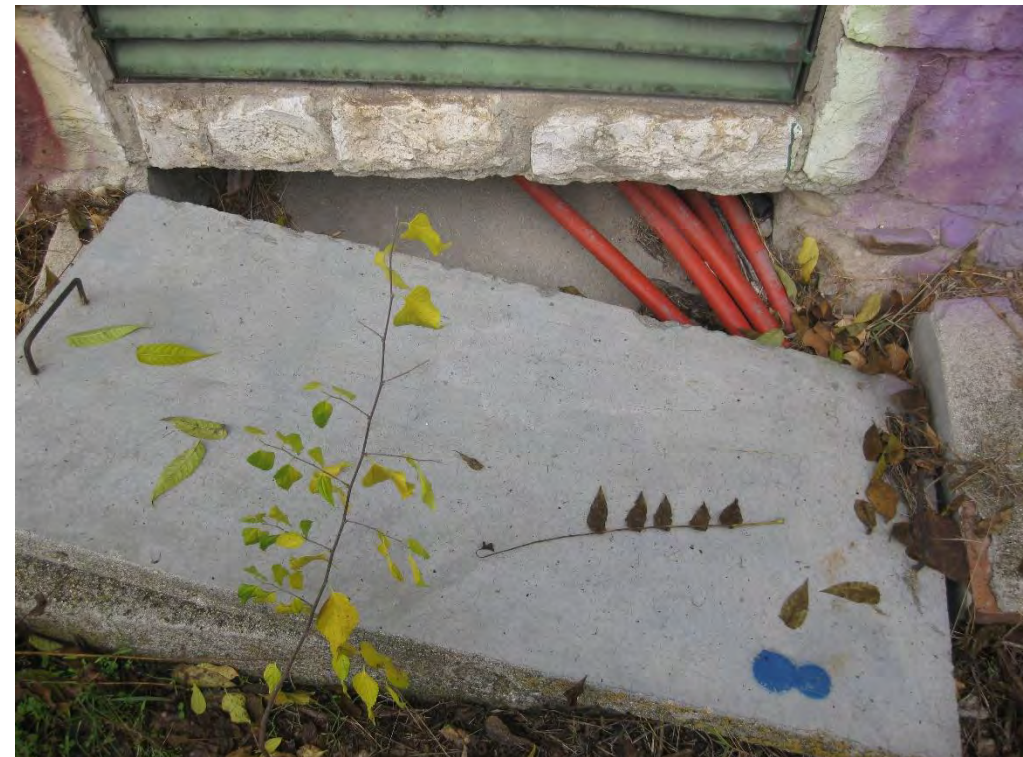
Foto 18 Entrada cableado a la subestación
