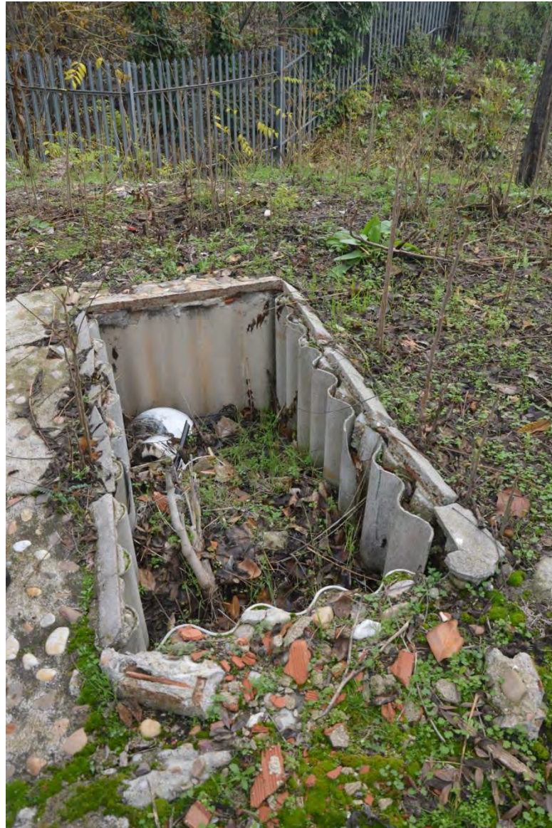
Foto 27 Arqueta con elementos de fibrocemento
