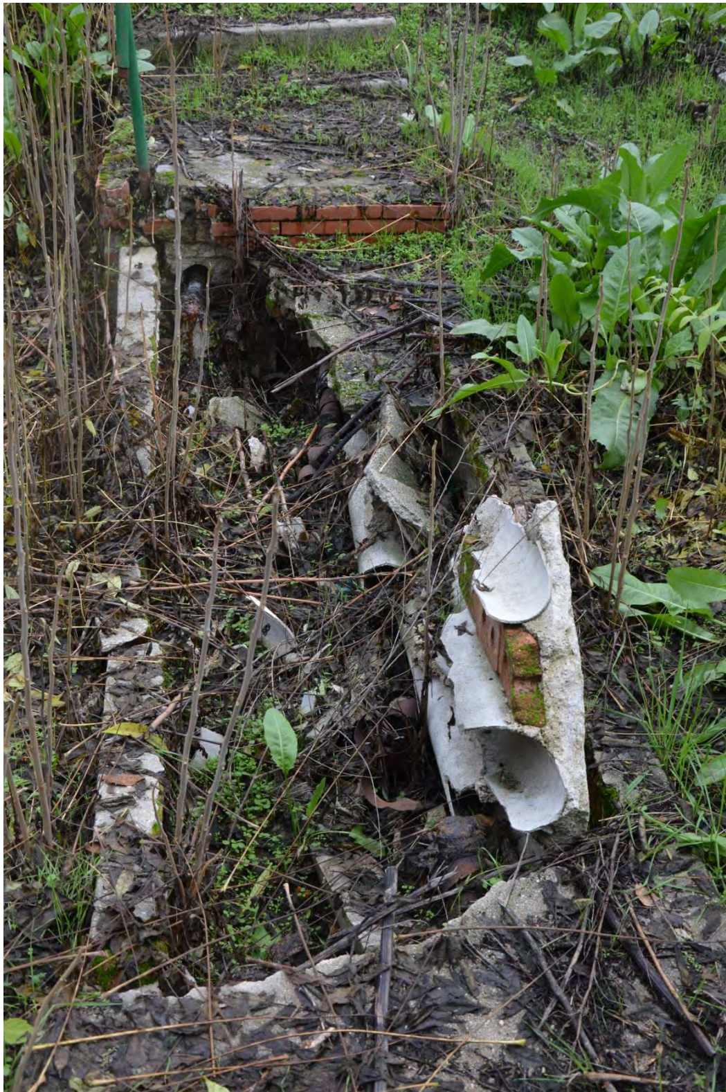
Foto 19 Antigua canalización de cableado que contiene fibrocemento
