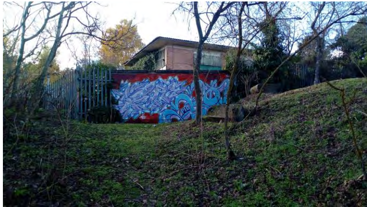
Foto 3 Pared de cerramiento a derribar y sustituir por vallado tipo PANZER
