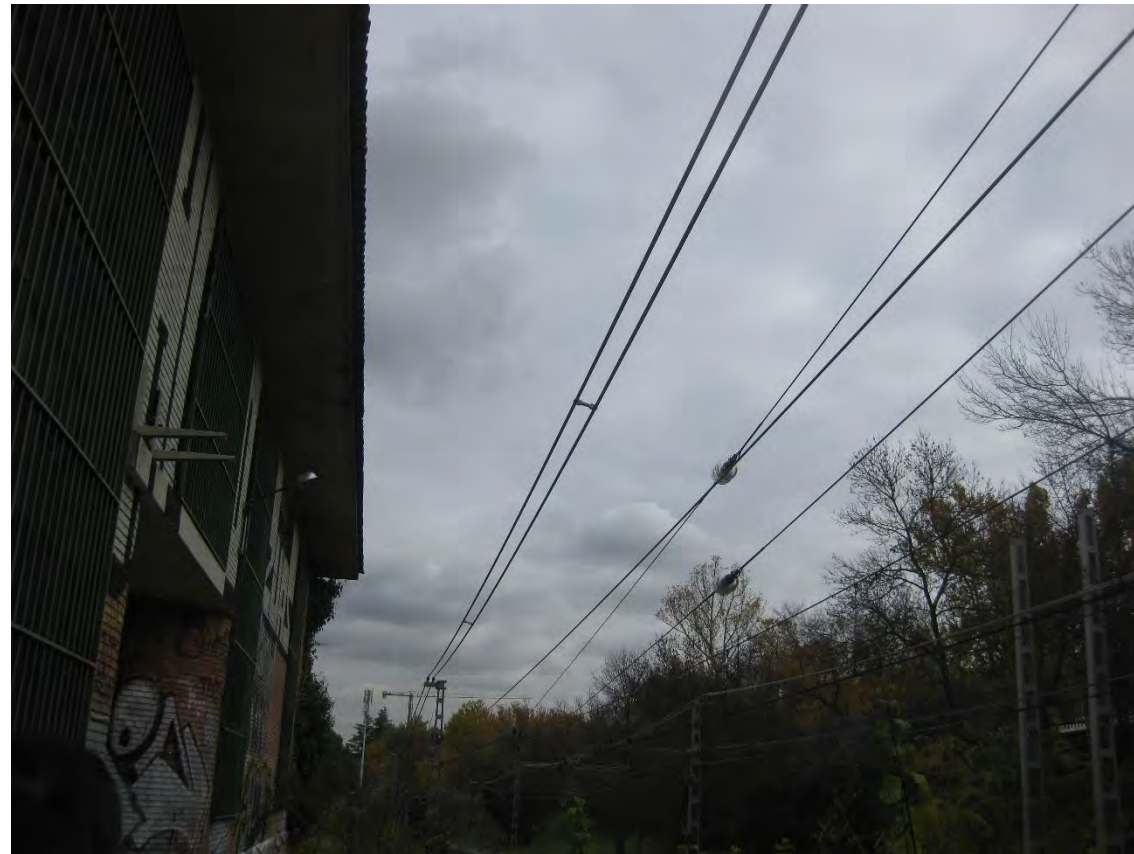
Foto 29 Distancia cornisa a feeders y catenaria
