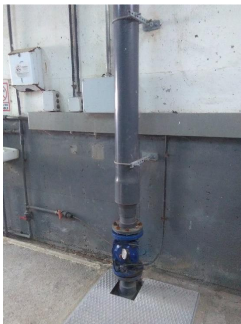
Ilustración 43: Tubería de desagüe del rototamiz de la EDAR Academia de Ingenieros
