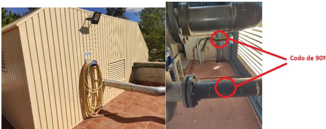
Ilustración 42: Tubería entrada al reactor biológico de la EDAR Academia de Ingenieros
