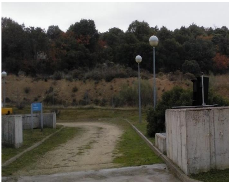
Ilustración 6: Firme de zahorra artificial (ZA) en la EDAR de Colmenar de Arroyo.
