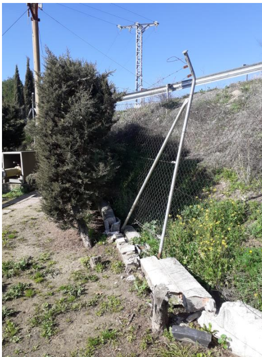
Ilustración 8: Tramo con gran reparación de murete necesaria en la EDAR Arroyo del Soto
