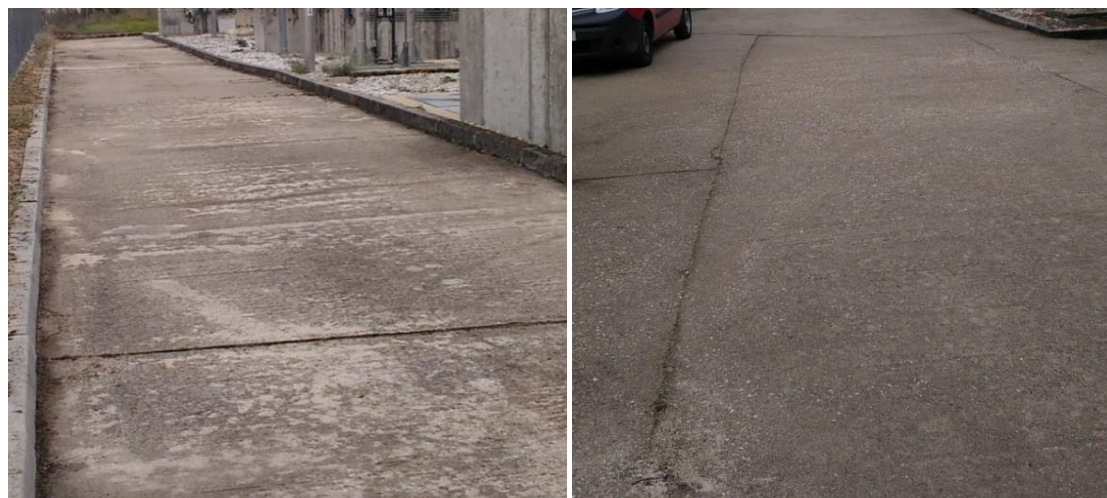
Ilustraciones 70 y 73: Firme de hormigón en la EDAR de San Martín. Apreciación de juntas erosionadas.
