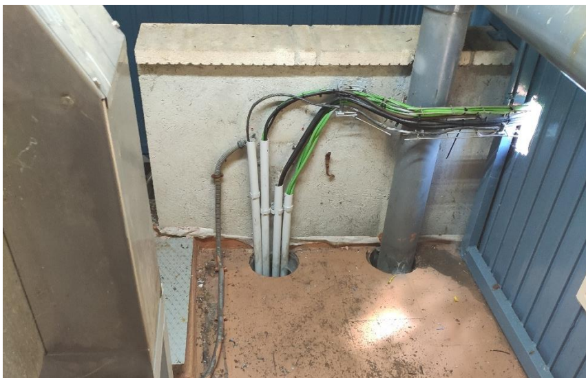
Ilustración 41: Conducción eléctrica y de agua pretratada de la EDAR Academia de Ingenieros
