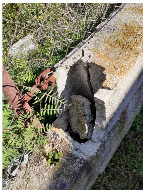
Ilustración 4: Alguno de los pequeños desperfectos a reparar en el vallado de la EDAR Arroyo del Soto (numerosos)
