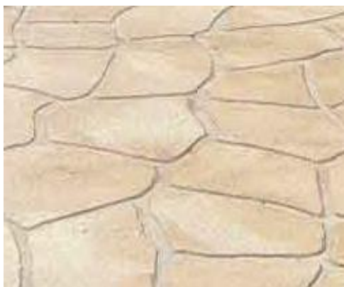
Ilustración 11: Pavimento de hormigón impreso.
