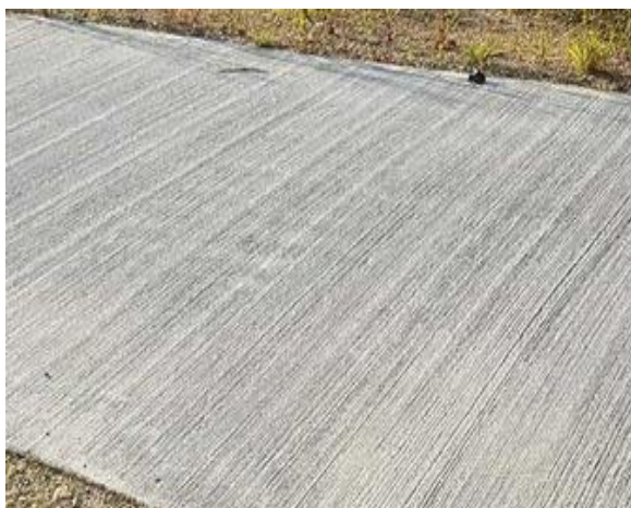
Ilustración 12: Pavimento de cemento ruleteado.
