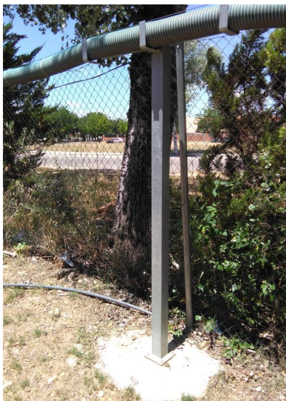
Ilustración 7: Modelo orientativo de soporte-tipo a instalar para tubo difusor en la EDAR Arroyo del Soto
