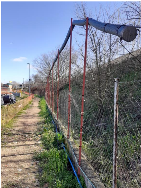
Ilustración 6: Tubo difusor a desmontar y reservar, y soportes actuales en la EDAR Arroyo del Soto
