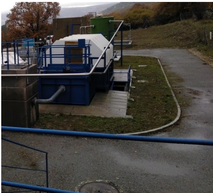
Ilustración 5: Pavimentos de MBC donde se observan pequeños hundimientos en las zonas de giro, acumulándose el agua de lluvia en la EDAR de Robledondo.
