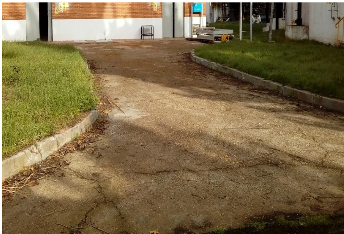
Ilustración 69: Pavimento de hormigón fisurado en la EDAR de Alcalá Este.
