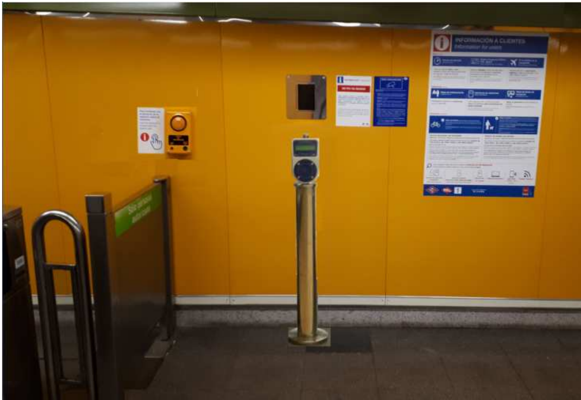
Figura 32: Disposición del interfono, lector TIC y la validadora.
