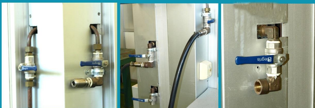
Canalizaciones de aire comprimido del Laboratorio (23 tomas)
