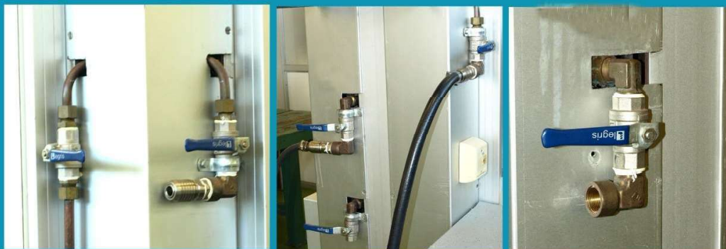
Canalizaciones de aire comprimido del Laboratorio (23 tomas)
