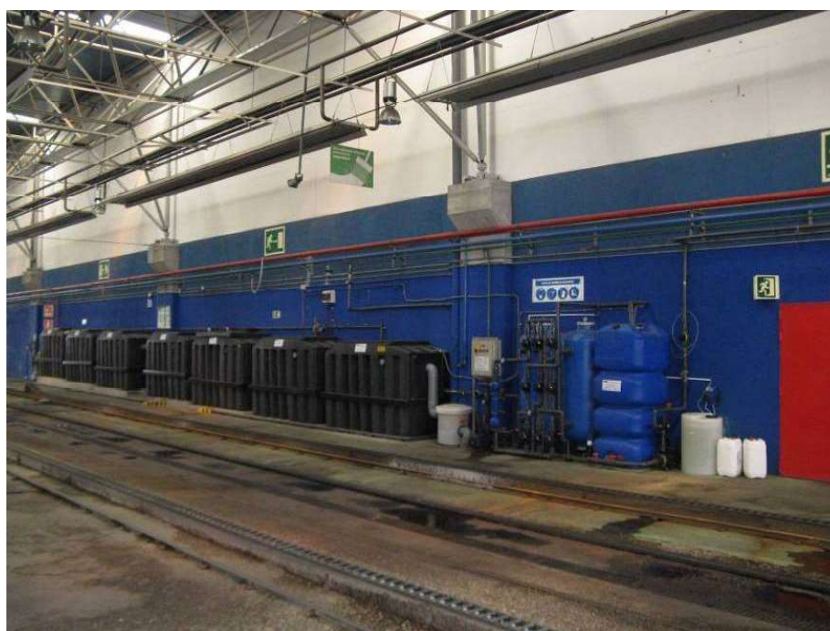
RECICLADORA AGUACLEAN: instalada en el túnel de lavado de LAGUNA.
