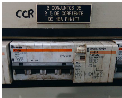
Figura 1. Posible protección eléctrica del actual CCR
