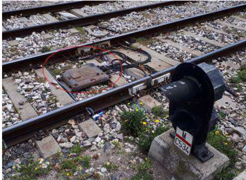
Ilustración 1. Juntas Inductivas afectadas
