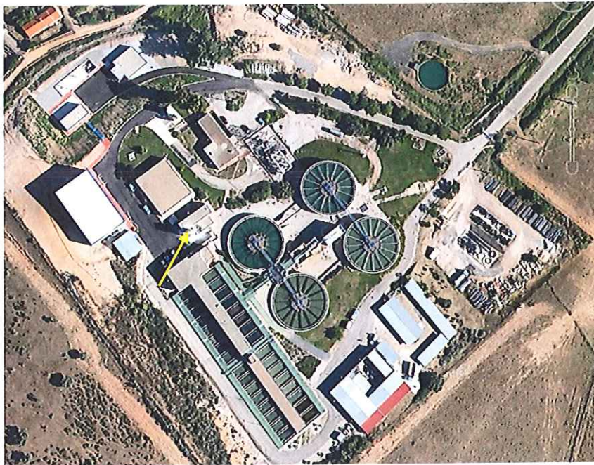
Fotografía 2: Ubicación del silo
