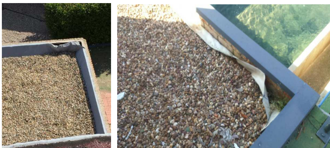
Imagen 5: Detalle falta adherencia entre tratamiento impermeabilizante y peto de la cubierta del Edificio de Telecontrol y filtros de Arena en la ETAP
