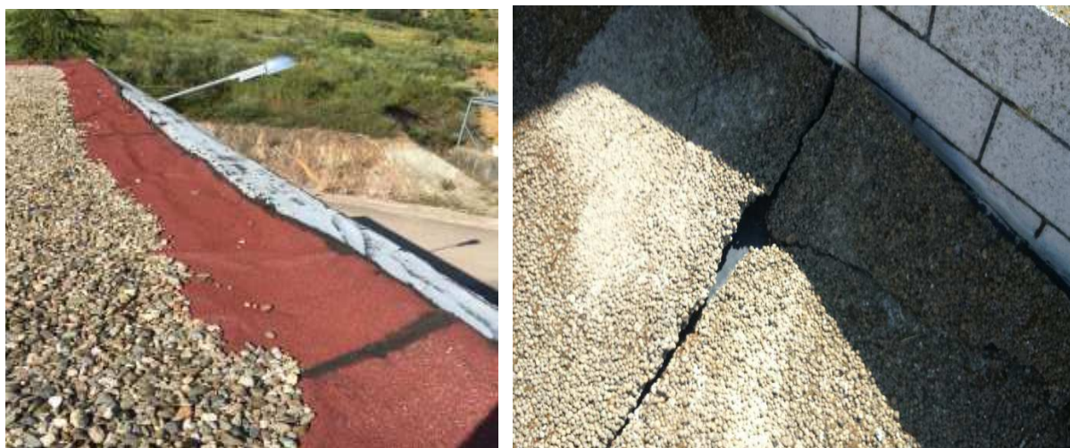
Imagen 7: Detalle rotura láminas impermeabilizantes
