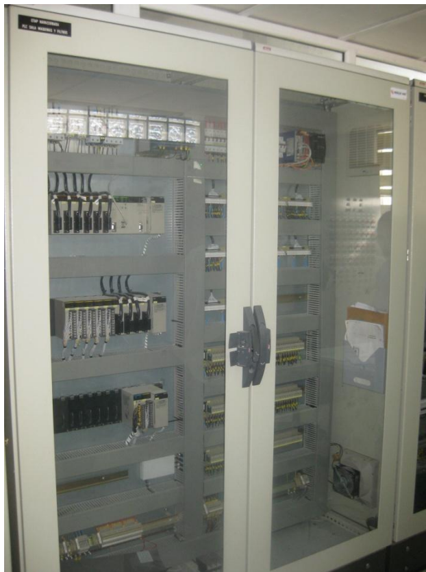
Fotografía 97: Cuadro control PLC de Filtros
