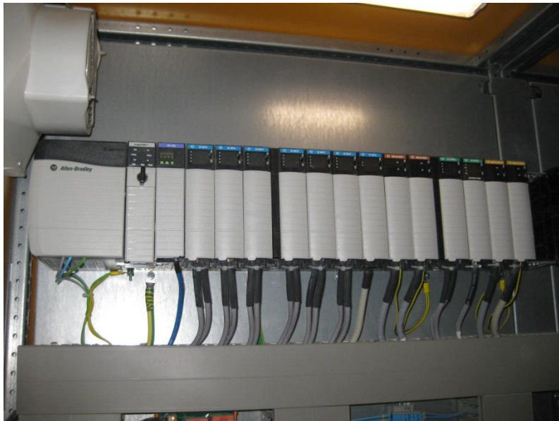
Fotografía 63: Cuadro de control PLC 04 – Tratamiento de fangos
