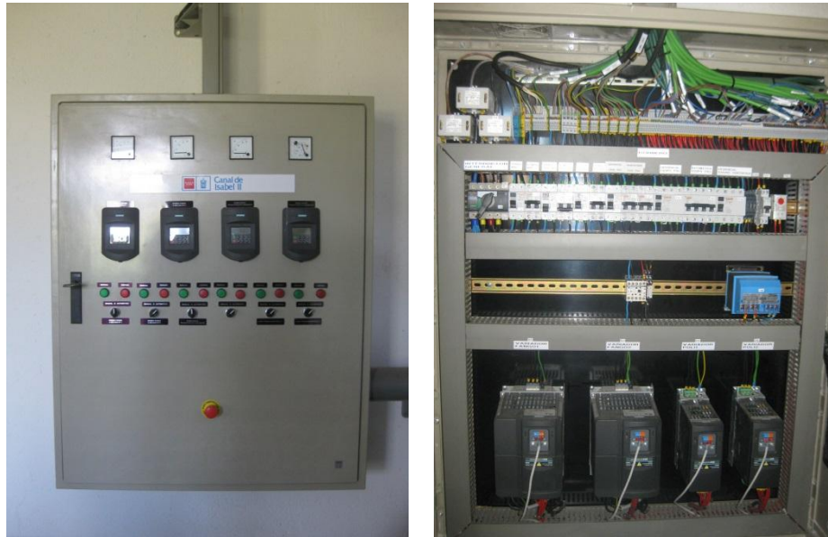
Fotografía 89: Cuadro variadores de frecuencia secado de fangos
