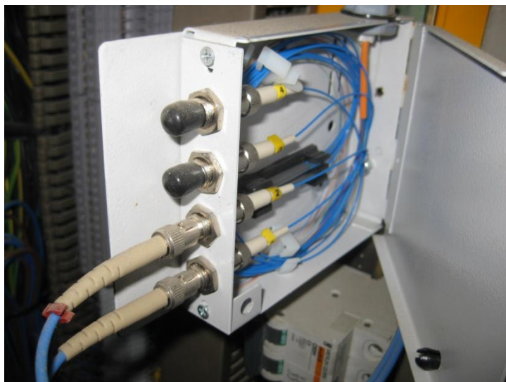
Fotografía 61: Detalle repartidor óptico
