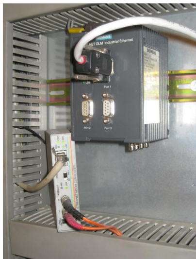
Fotografía 37: Switch y tarjeta Ethernet PLC13
