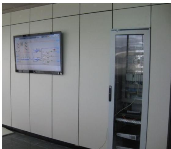
Fotografía 114: Ejemplo cuadro de comunicaciones sala de control.
