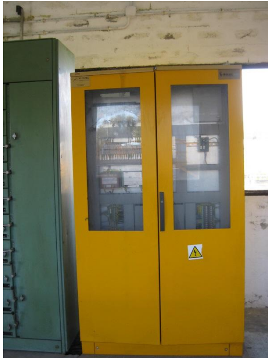
Fotografía 21: PLC02 Decantación primaria
