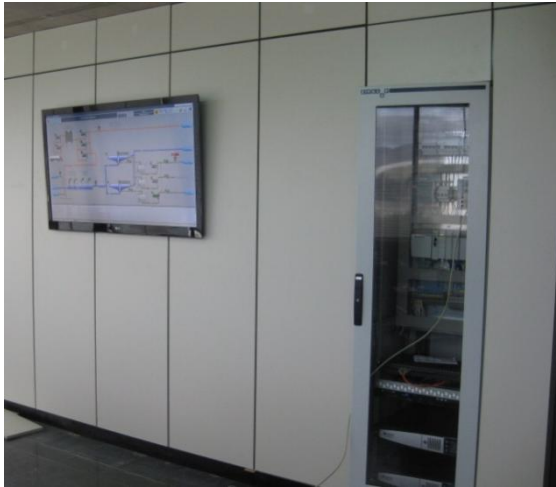
Fotografía 100: Ejemplo cuadro de comunicaciones sala de control.
