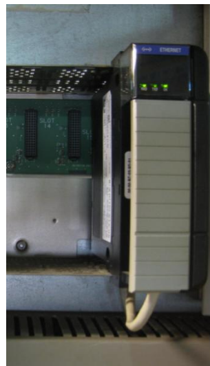
Fotografía 34: Switch y tarjeta Ethernet PLC12
