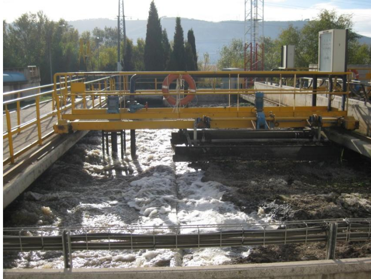
Fotografía 41: Puente desarenador EDAR Alcalá Oeste
