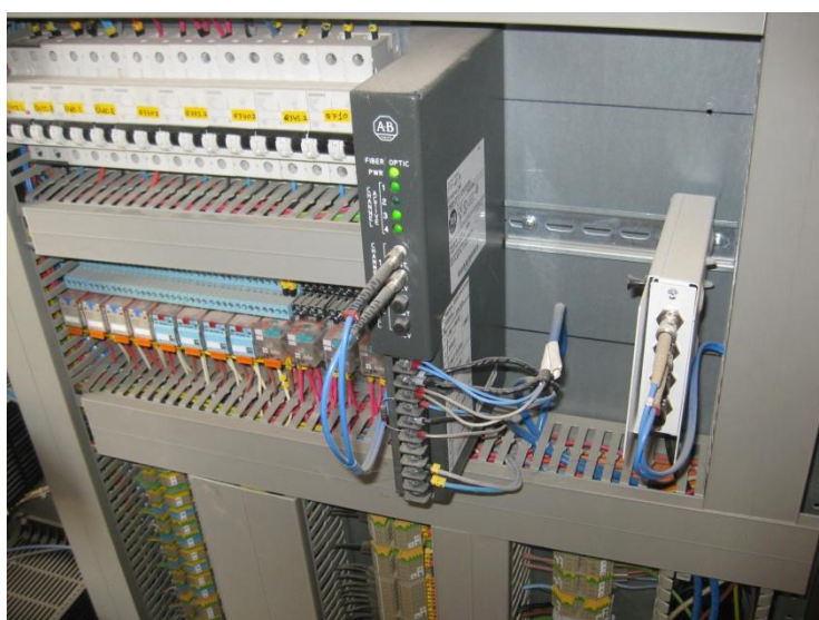
Fotografía 64: Convertidor y repartidor óptico CCM 4
