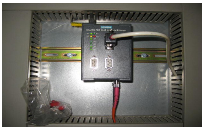
Fotografía 19: Switch y tarjeta Ethernet PLC01
