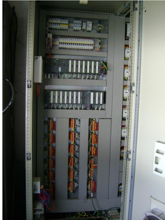
Fotografía 108: Cuadro control PLC de Maquinas
