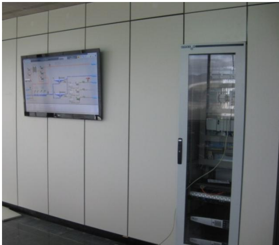
Fotografía 39: Ejemplo cuadro de comunicaciones sala de control.
