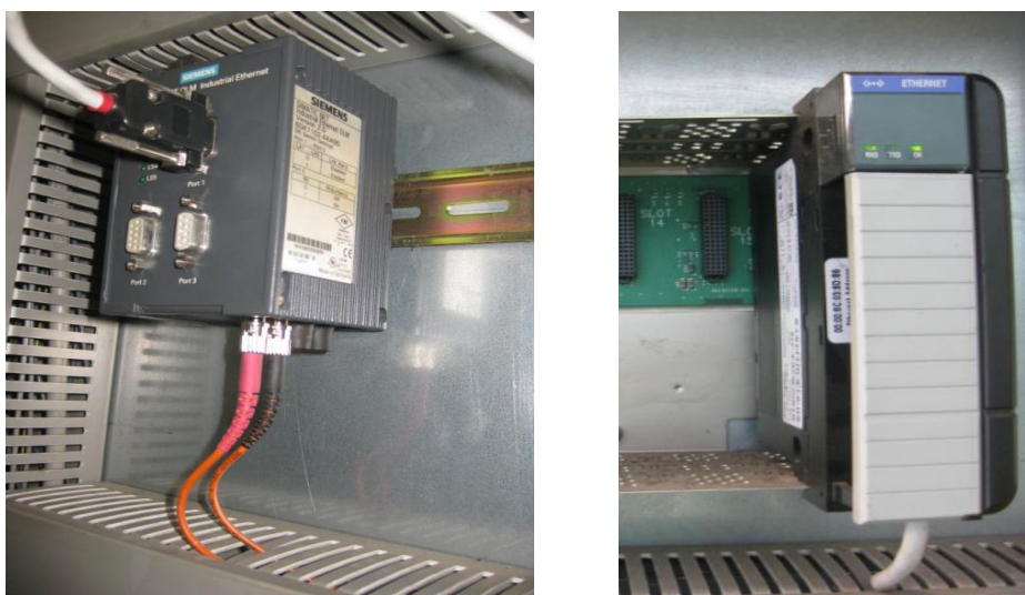
Fotografía 25: Switch y tarjeta Ethernet PLC04
