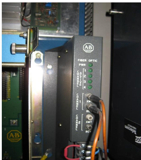
Fotografía 53: Detalle del Convertidor DH+
