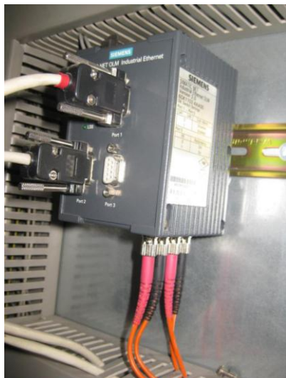
Fotografía 34: Switch y tarjeta Ethernet PLC12
