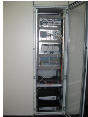
Fotografía 39: Ejemplo cuadro de comunicaciones sala de control.
