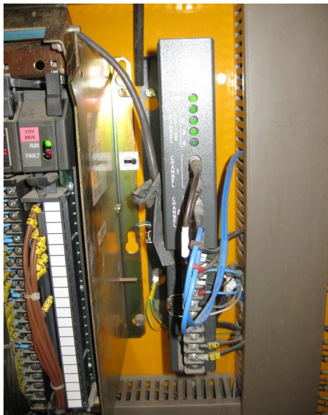
Fotografía 60: Detalle convertidor DH+
