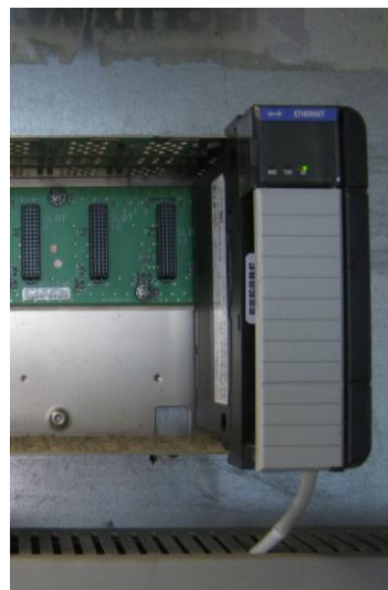
Fotografía 28: Switch y tarjeta Ethernet PLC05
