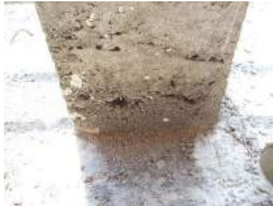
Defecto de falta de vibrado en base de pilar.
