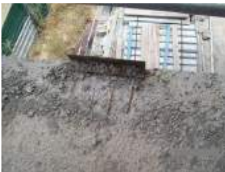
Placa con armadura a la vista. Las barras superiores no funcionan.
