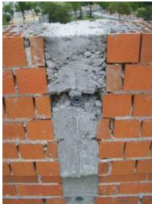
Machón de refuerzo de la fábrica de petos de cubierta. Muy mal ejecutados, y seccionados.
