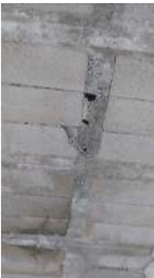
Grandes coqueras en nervios de forjado, que dejan la armadura desprotegida.
