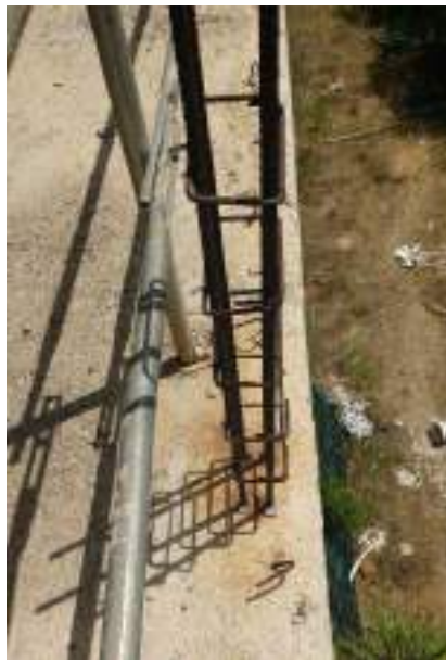
Armadura del machón de refuerzo de fábricas.
