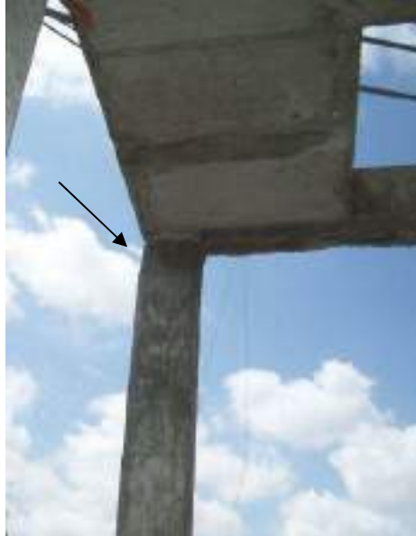
Desviación de cabeza de pilar.
