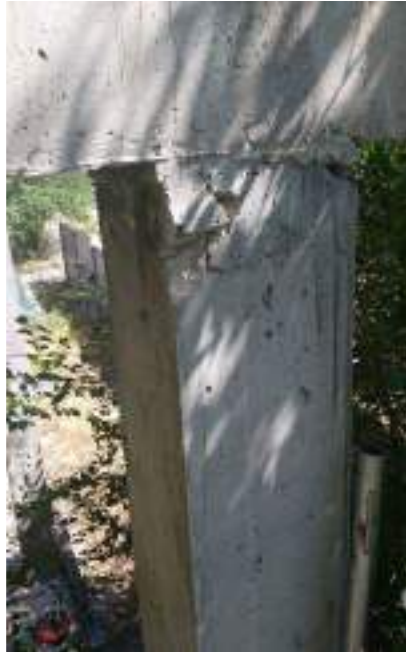
Rotura en cabeza de pilar, por mala operación en el momento del hormigonado del mismo.
