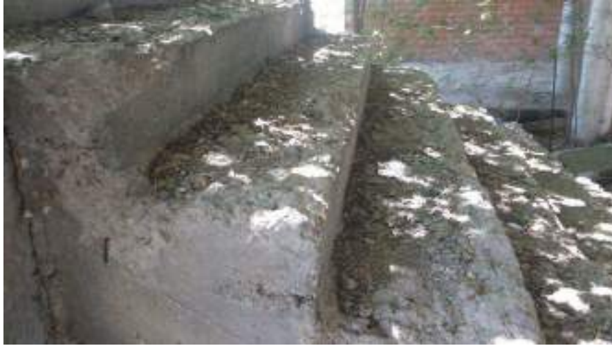
Peldaños con hormigón de la escalera central descarnados. Habría que recomponerlos.
