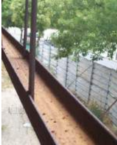
Los cargaderos de huecos de fachada, tienen un cierto grado de oxidación
