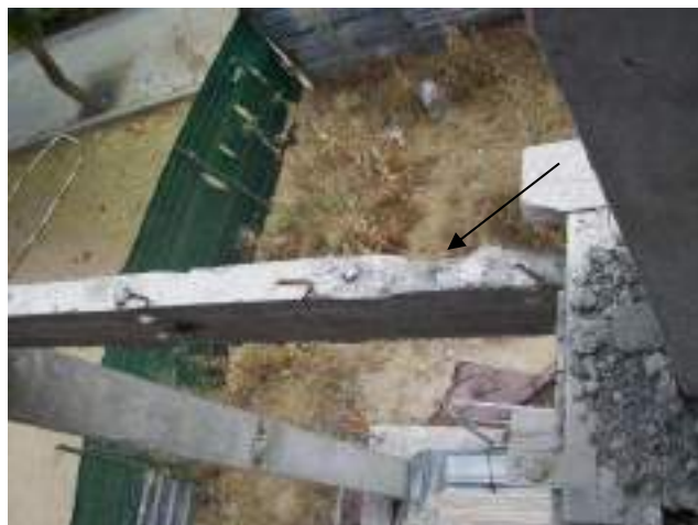
Viga de atado de pórtico de escalera, muy deteriorada.
