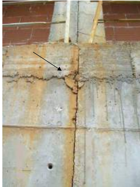
Despunte de hormigón por contacto de la junta.
