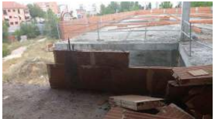
Este tramo de fábrica “reforzada”, se bamboleaba, he incluso se podía tirar.
