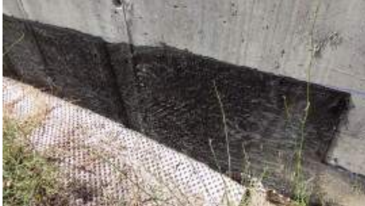
La lámina impermeabilizante ha quedado expuesta, y no son láminas d exterior.
