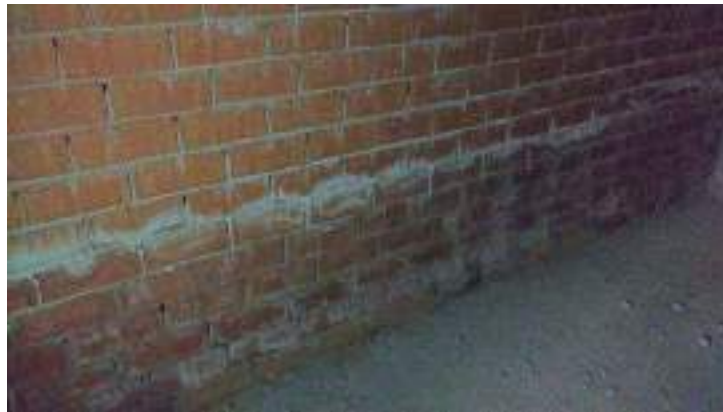
La fábrica de sótanos tiene, en prácticamente todos los casos, manifestación de sales por humedad en los arranques.
