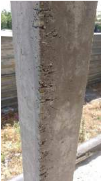
Pérdida de finos del hormigón, por falta de estanquidad de los encofrados.
