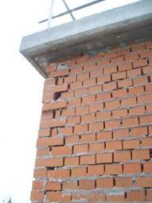
Fabrica muy mal ejecutada y mal trabados los enjarjes.
