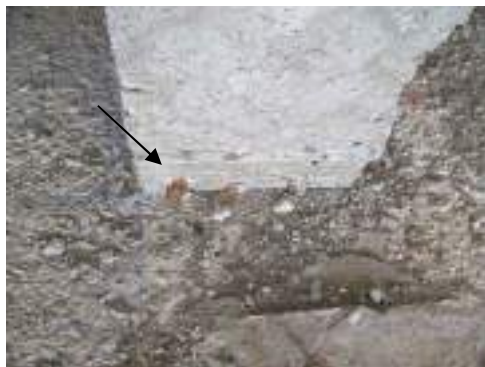
En esta imagen se observan esperas de armadura que vienen de abajo mal situadas, y han tenido que grifarse para continuar. Dichas barras, no funcionan estructuralmente por su brusquedad en el doblado, además de estar expuestas.
