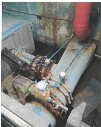
Oxidación en piezas embridadas (sala 1) y filtraciones por fisuras en las tuberías (sala 2).
