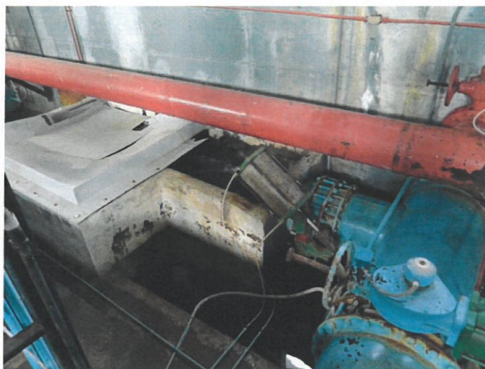
Oxidación en piezas embridadas (sala 1) y filtraciones por fisuras en las tuberías (sala 2).
