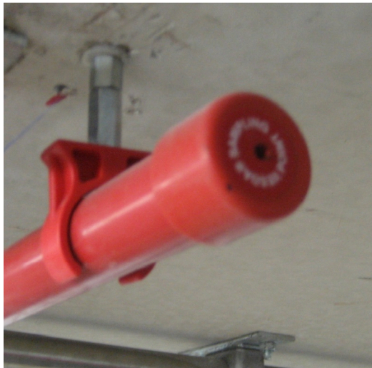
Soporte tubería ABS y orificio aspiración final
