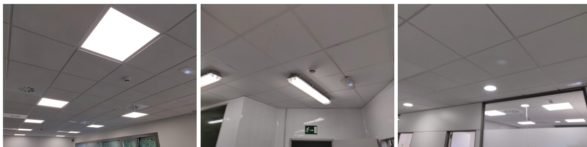
Figura 2: Fijos a falso techo con placas
