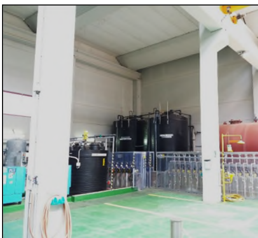
Zona de almacenamiento y dosificación de reactivos
