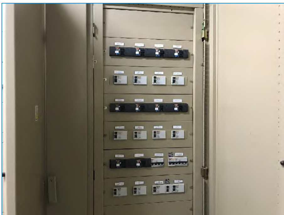
Fotografía n.º 22. Cuadro general de distribución de baja tensión en margen derecha 1
