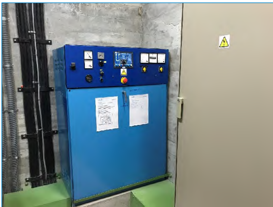
Fotografía n.º 24. Cuadro de conmutación Red-Grupo electrógeno
