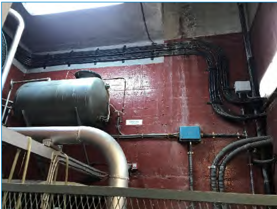
Fotografía n.º 17. Depósito elevado de combustible para grupo electrógeno
