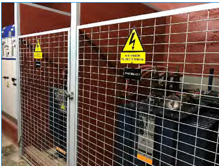
Fotografía n.º 14. Sala de alta tensión en galería 867. Transformadores (1+1)
