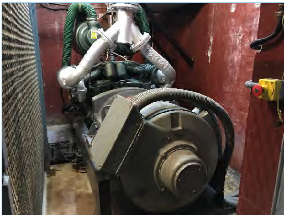
Fotografía n.º 13. Grupo electrógeno en sala subterránea de alta tensión (Galería 867)
