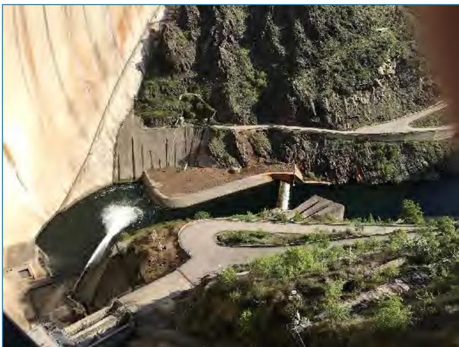
Fotografía n.º 4. Vista Presa aguas abajo, desagüe de fondo e intermedio
