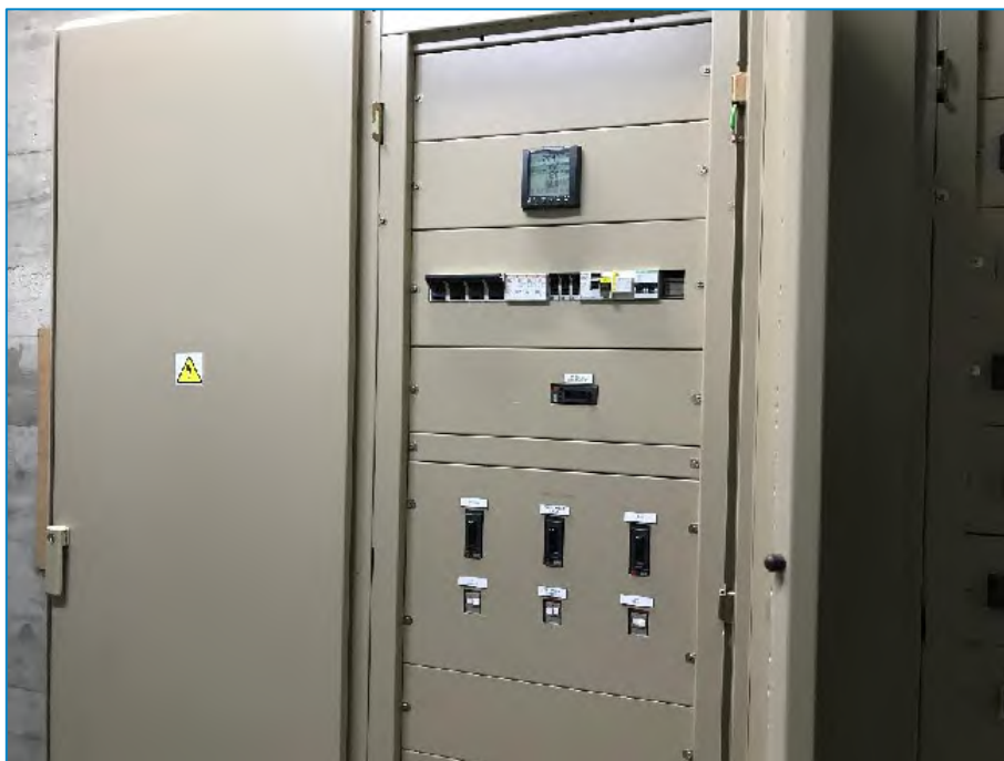
Fotografía n.º 23. Cuadro general de distribución de baja tensión en margen derecha 2
