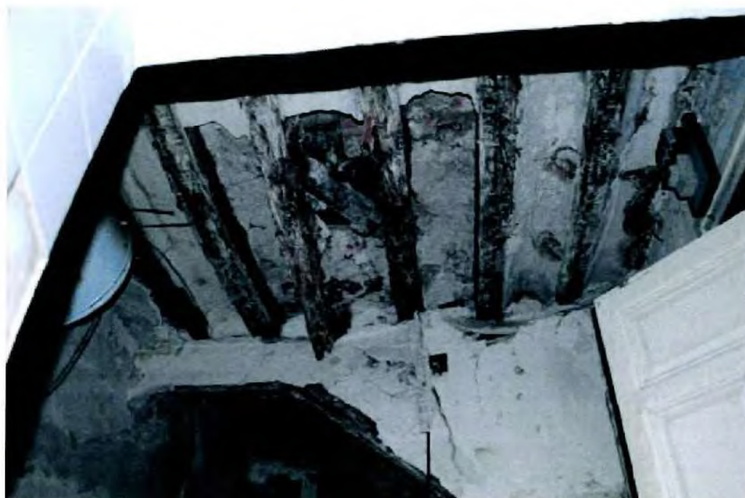
Detalle cara inferior forjado
