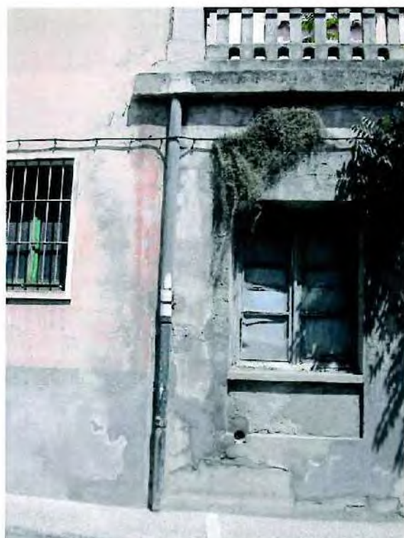
Detalle de bajante en fachada
