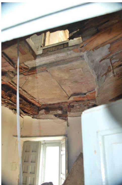
Forjado colapsado
