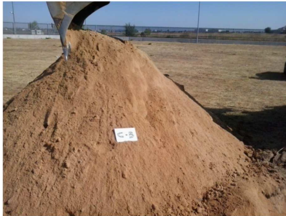
Excavación de Calicata C-3 en arena tosquiza
