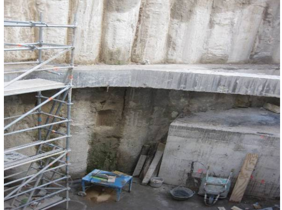
Pozo P-1, construido con una cortina de pilotes tipo secantes; comportamiento estanco -Oct. 2010
