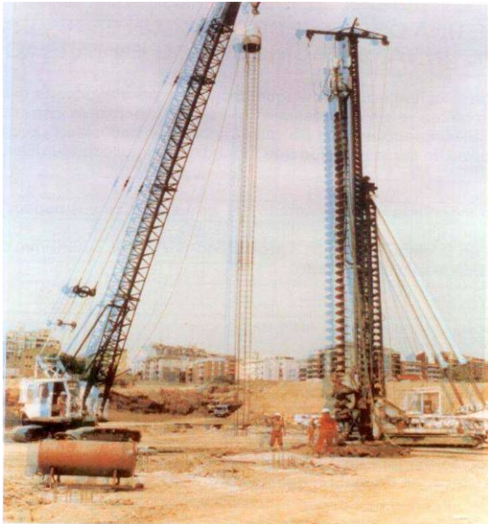
Imagen grúa con barrena continua de pilotes CPI8_Esquema operativo de perforación y hormigonado en sentido ascendente.
