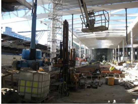
Remodelación Estación de Atocha Fase2: Vista de la marquesina y prospecciones control de mejora de Jet grouting
