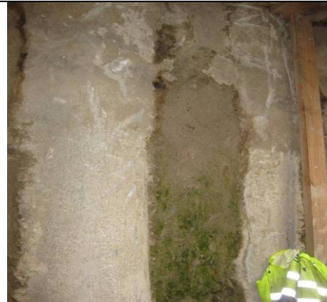
Detalle de la transmisividad de humedad del pilote de mortero. No hay afloramiento de agua, comportamiento estanco.
