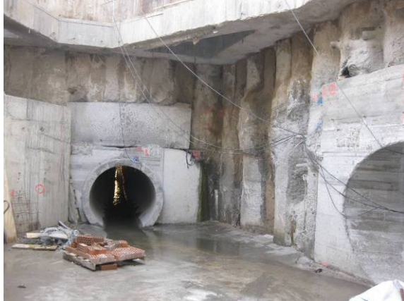
Vista del pozo P-1, con los alcantarillados de: escudo abierto y cerrado construidos; Oct. 2010
