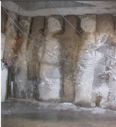
Detalle de las humedades contenidas en el trasdós de muro, aflorantes solo por pilotes de mortero. Intradós con acumulación de aguas pluvial reciente.- Oct.2010
