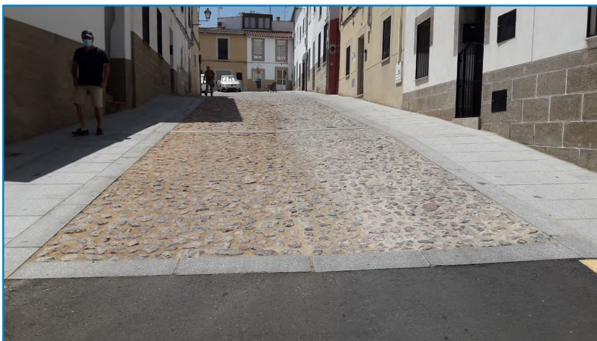
Figura 14: Calle Picadero cambio de pavimento
