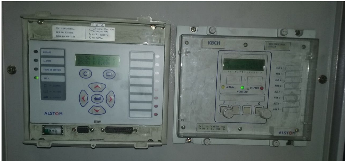
Figura 2: Relé de sobrecarga y cortocircuito
