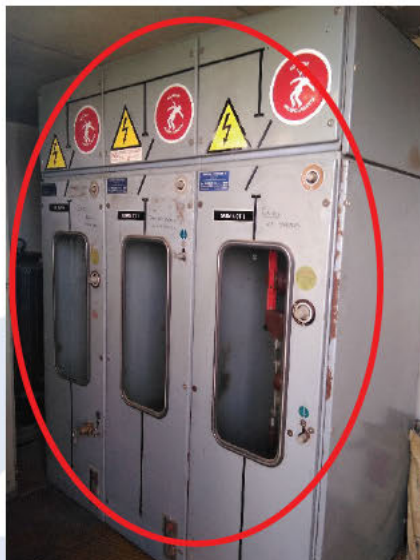
Celdas a retirar y sustituir por celdas de entrada, protección y salida.
