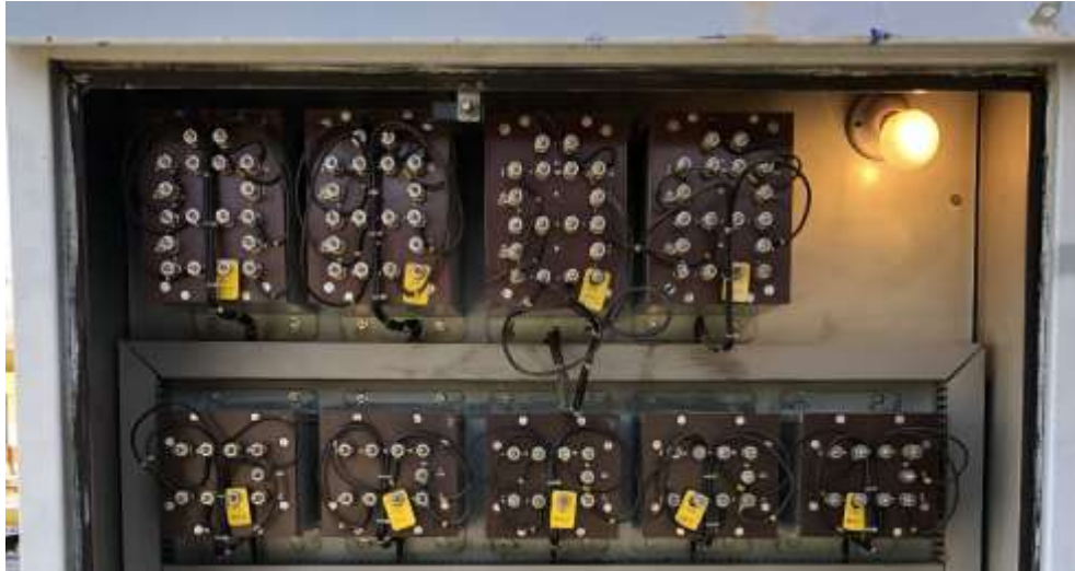
Transformadores tipo Sainco situados en los armarios en vía
