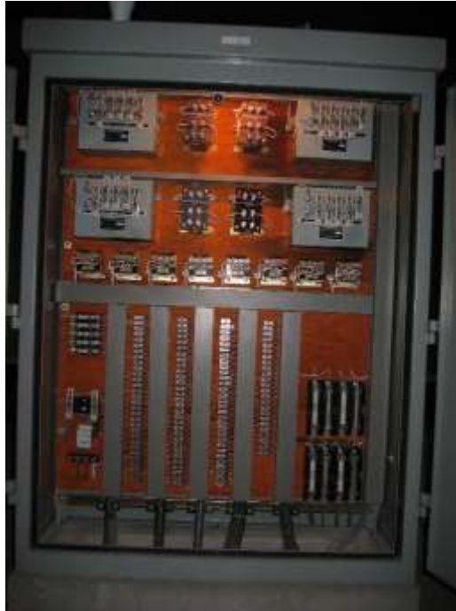
Fusibles y portafusibles del armario de vía.
