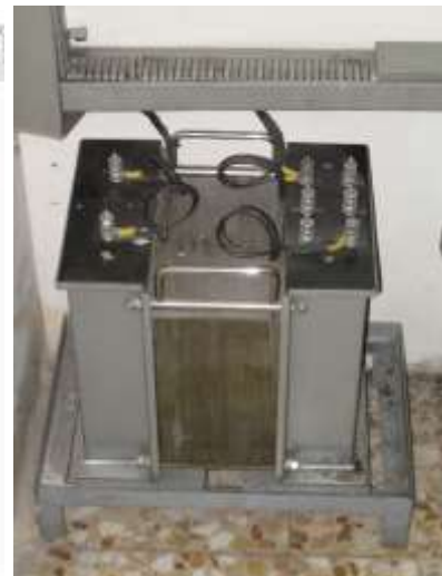
Transformadores en armarios y enclavamientos de Ericsson
