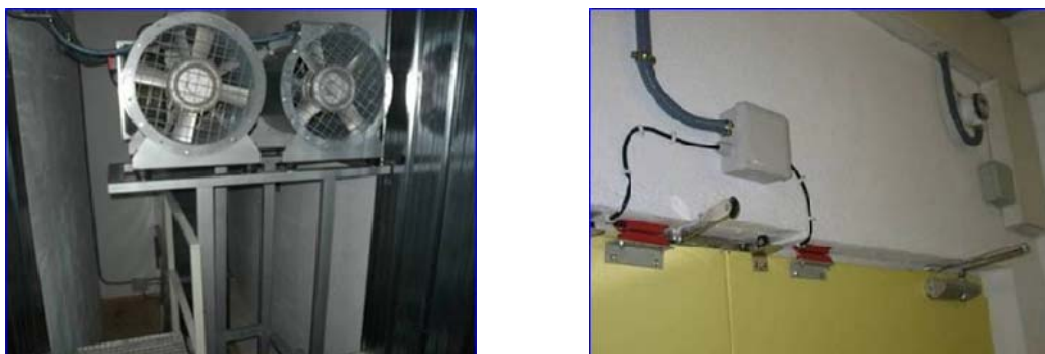
Figura 14 Ventiladores de extracción y elementos de control del sistema de presurización en salida de emergencia
