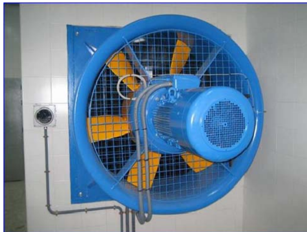
Figura 6 Ventilador de estación
