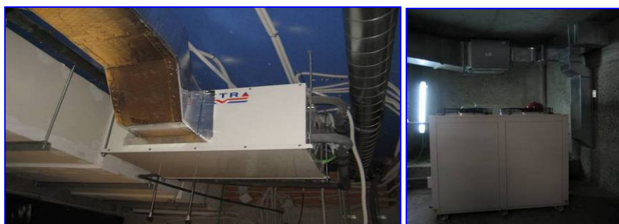
Figura 15 Unidades exteriores de climatización
