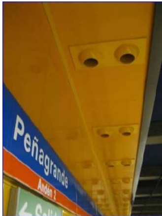
Figura 7 Toberas de ventilación en estación
