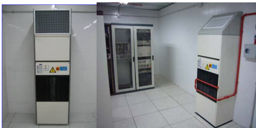
Figura 16 - Equipos de refrigeración en cuartos técnicos
