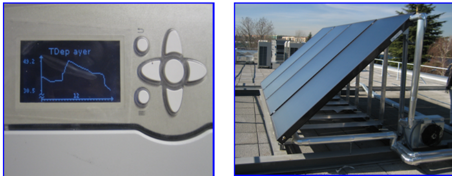
Figura 19 Placas solares térmicas y visualización de control
