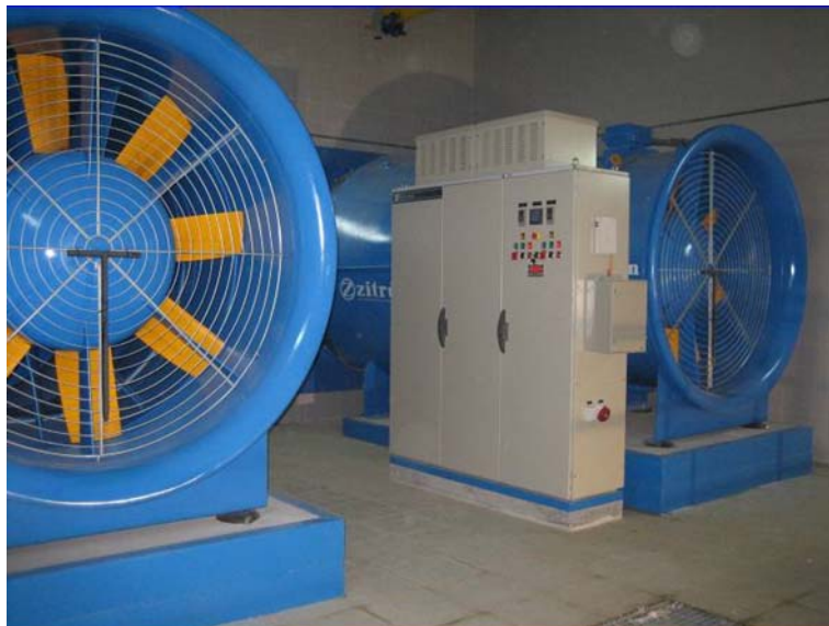
Figura 9 Ventiladores instalados en túneles de interestación
