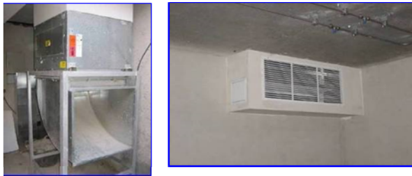
Figura 12 Conducto y compuertas de extracción de humos
