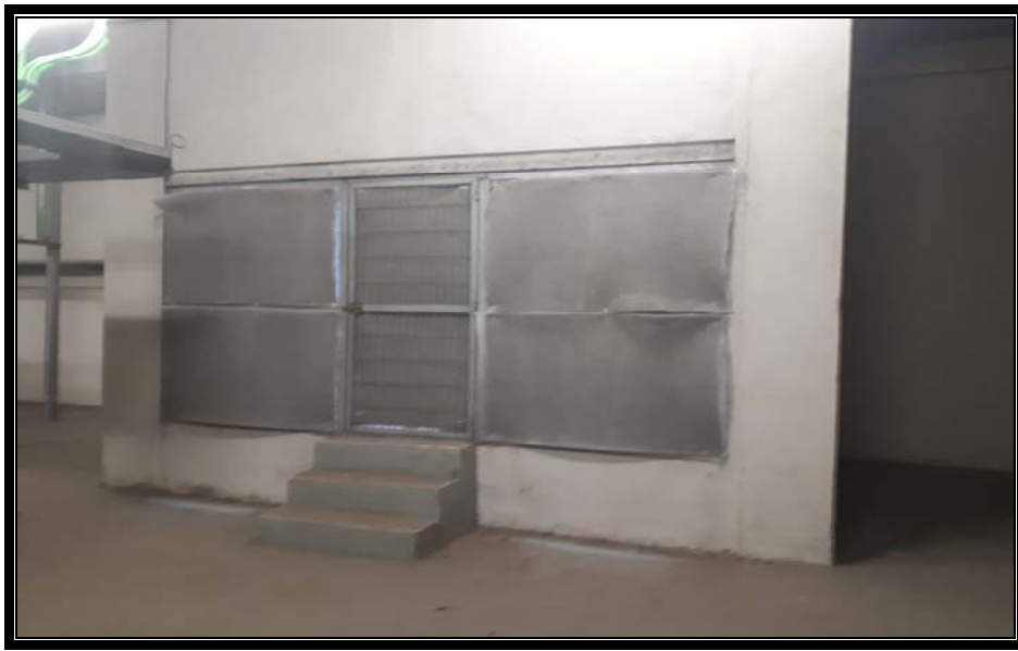
Figura 4: Ejemplo de puerta de comunicación con pozo de ventilación dotada de filtros a sustituir.
