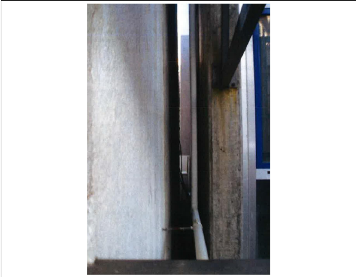
SEPARACIÓN DEL EDIFICIO JUNTO A LA MEDIANERA OESTE (ZONA DE PASO DE INSTALACIÓN DE GAS)
