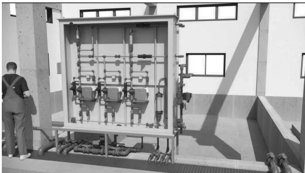
Imagen nº3: Estructura de PRFV para armario de dosificación.
