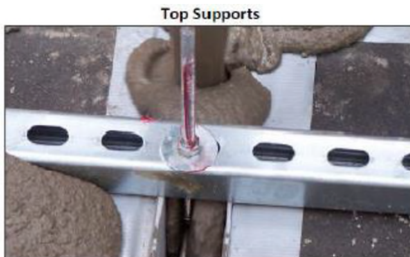
Figura nº 10. Soportes superiores que sujetan los falsos fondos durante la colocación del mortero que los embebe. Ese perfil superior se retira una vez el mortero ha fraguado.
