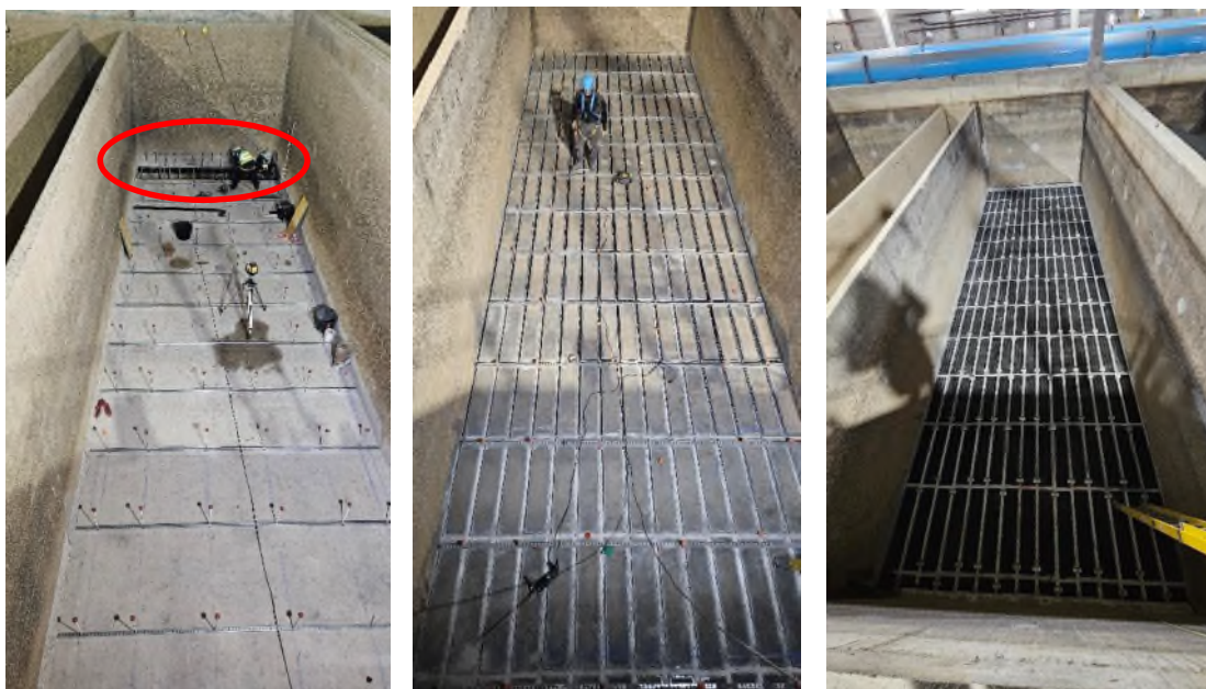
Figura nº 12. Fotografías de actuación propia de Canal de Isabel II en la ETAP de Valmayor en la reparación de los falsos fondos de filtros de carbón activo que está en ejecución en estos momentos. De izquierda a derecha: 1) perfilera inferior, 2) perfilera superior sobre los falsos fondos colocados y 3º) placas de anclaje definitivas. (En la foto izquierda se marca también la “canaleta” de recogida de agua producto que es necesaria en la colocación longitudinal de los falsos fondos y que se comentará a continuación).
