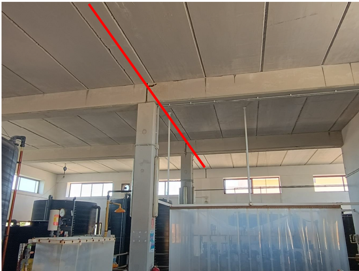
Figura nº 8. Fila de placas alveolares que no se eliminará para mantener el arriostramiento transversal de los sucesivos pilares, (en particular el extremo en la pared), sin necesidad de recurrir al perfil metálico proyectado.
