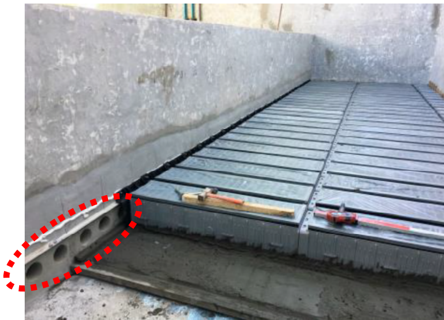
Figura nº 14. Pasamuros en muro en la colocación transversal de los falsos fondos.
