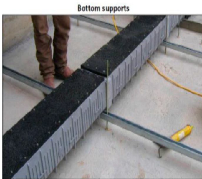
Figura nº 9. Varillas de soporte y perfil inferior de apoyo para montaje de los falsos fondos
