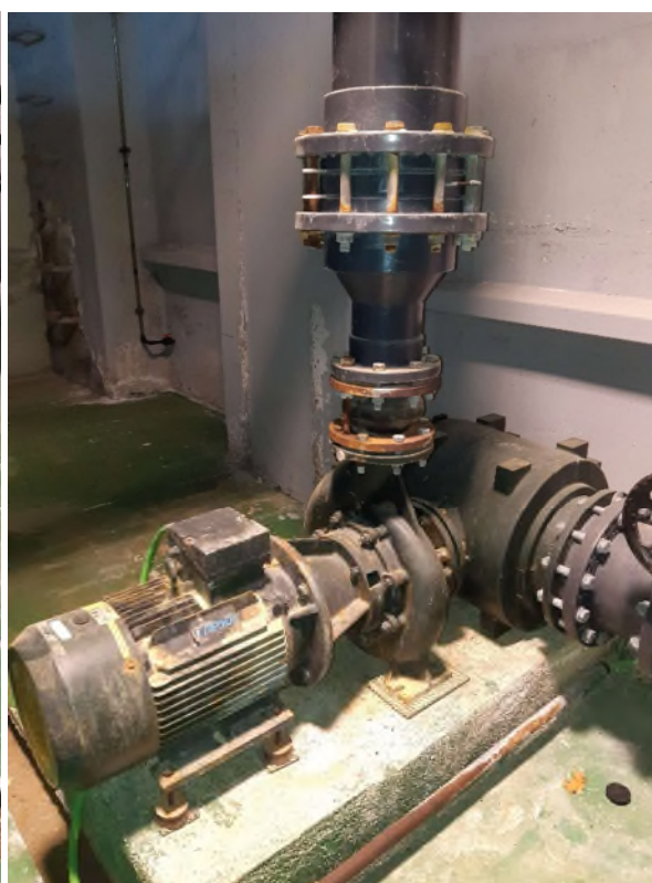
Ilustración 5. Bombas de filtración.
