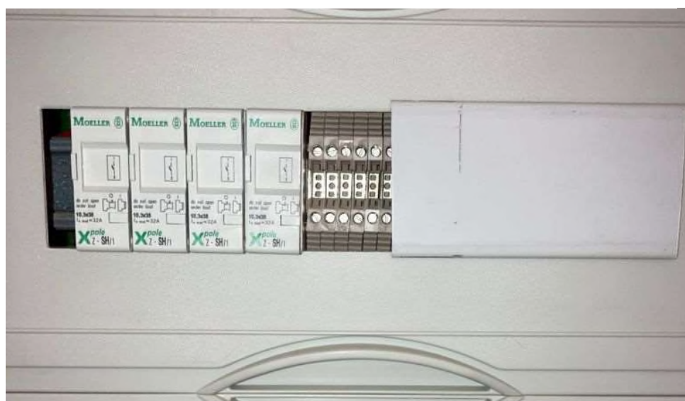
Ilustración 19. Ausencia tapa obturadora.
