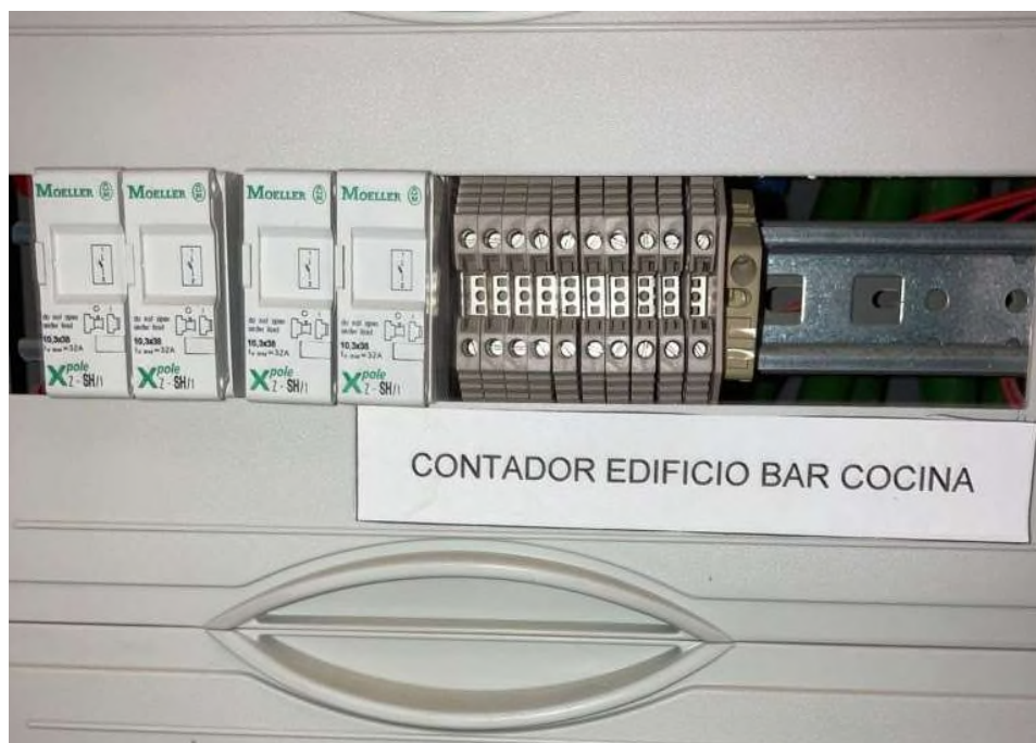
Ilustración 18. Ausencia de tapa obturadora.
