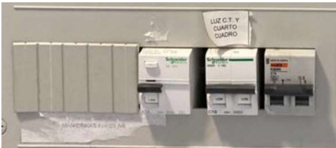
Ilustración 20. Interruptor diferencial averiado.
