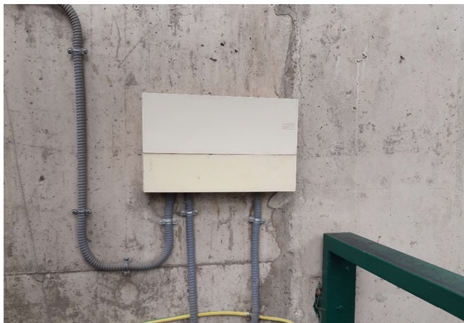
Ilustración 23. Envolvente de cuadro a sustituir y falta de rotulación del mismo.
