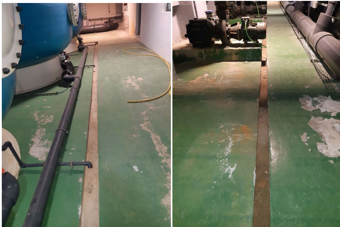
Ilustración 11. Zanja donde instalar canaleta PVC.
