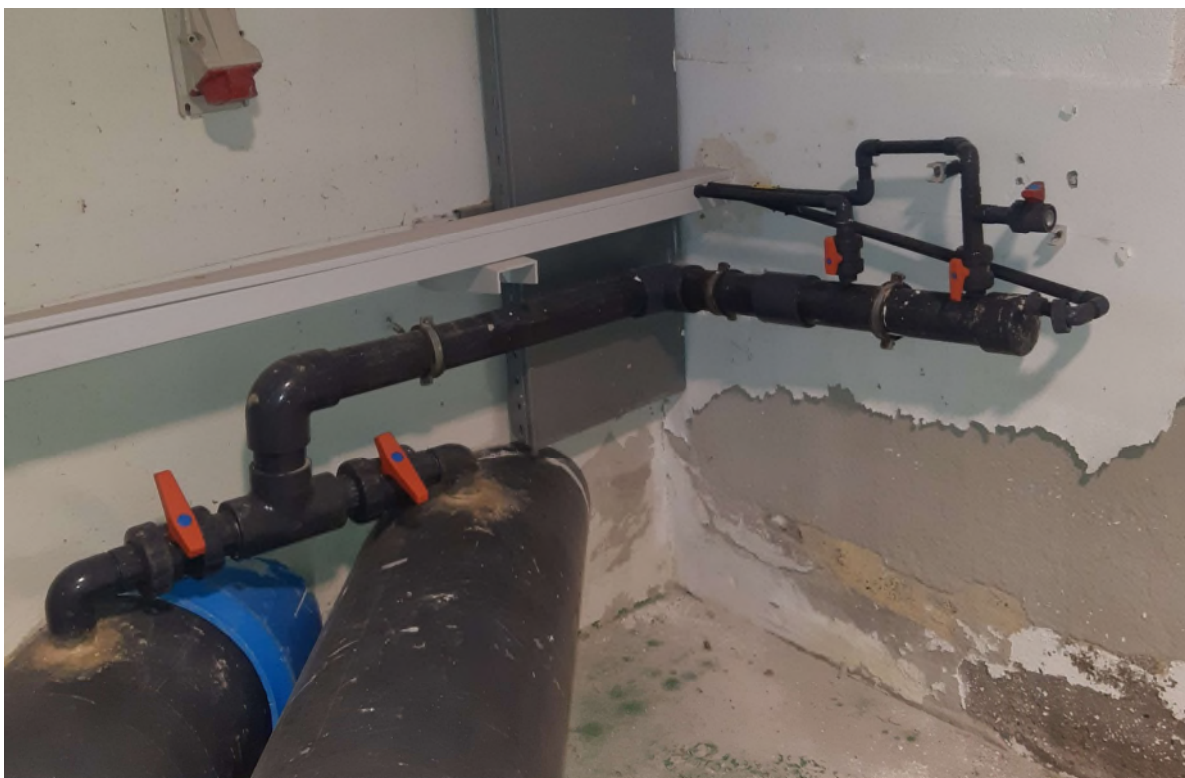
Ilustración 3. Sistema actual de inyección de químicos.
