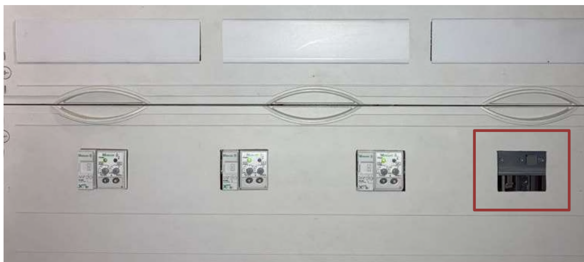
Ilustración 16. Ausencia de tapa obturadora.
