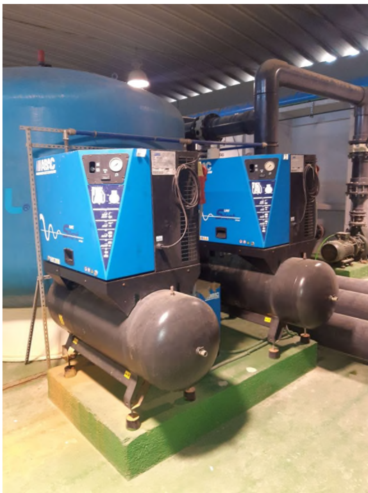
Ilustración 6. Compresores de aire.
