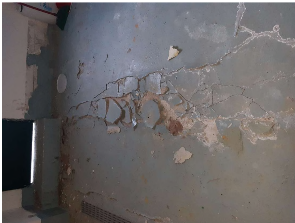
Ilustración 10. patología en solera de hormigón.
