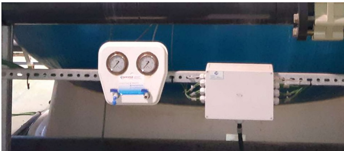
Ilustración 2. Panel de manómetro a sustituir.
