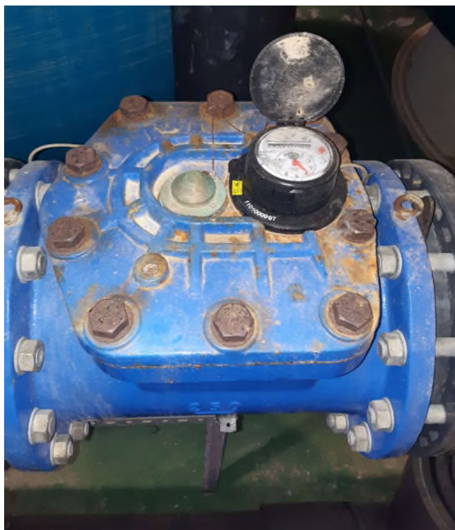
Ilustración 4. Contador de agua depurada filtro
