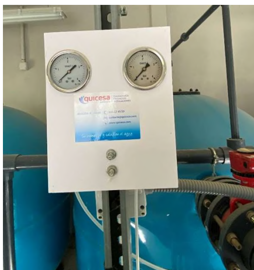
Ilustración 7. Panel de manómetros.
