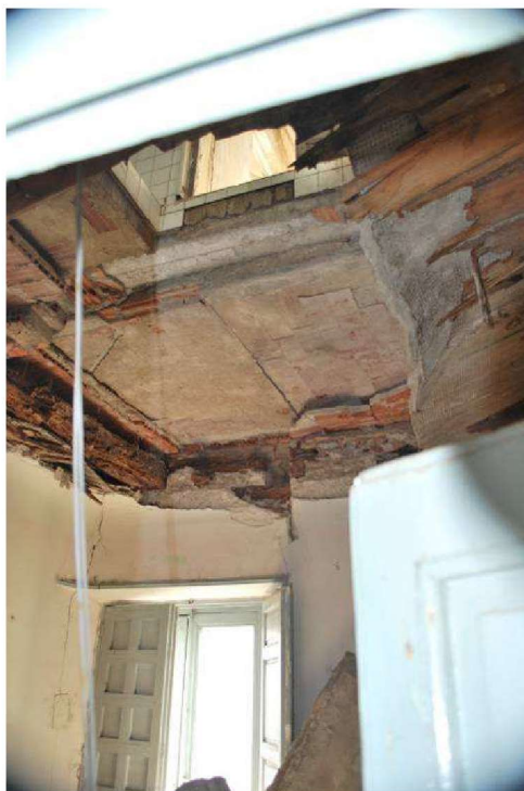
Forjado colapsado
