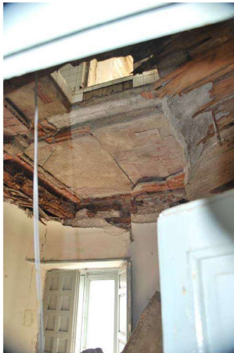
Colapso forjado
