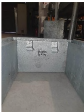
Imágenes 7 y 8. Sistema de cierre parte interior de la arqueta con dos candados SAG
