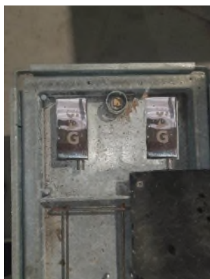
Imágenes 5 y 6. Sistema de cierre parte superior de la arqueta con dos candados SAG
