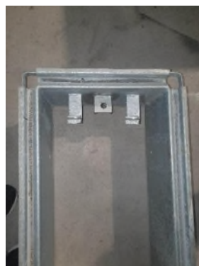
Imágenes 7 y 8. Sistema de cierre parte interior de la arqueta con dos candados SAG
