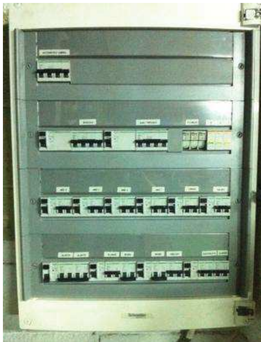
Figura 3: Ejemplo de etiquetado de cuadro eléctrico
