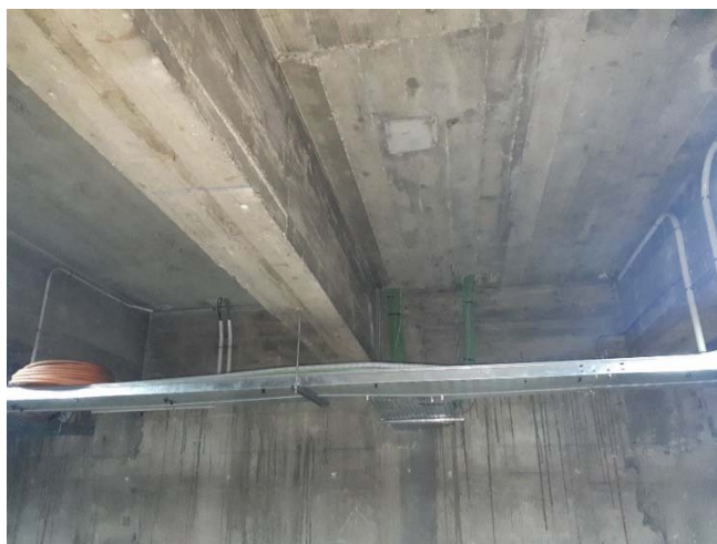
Figura 13, Bandeja inferior de alimentación Racks de control y comunicaciones.
