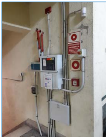
Figura 11. Central de incendios, pulsador, sirena y sistema de aspiración.
