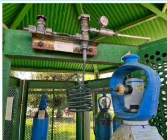
Cambio Colector Central Oxígeno
