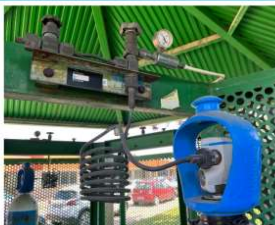
Cambio Colector Central Nitrógeno
