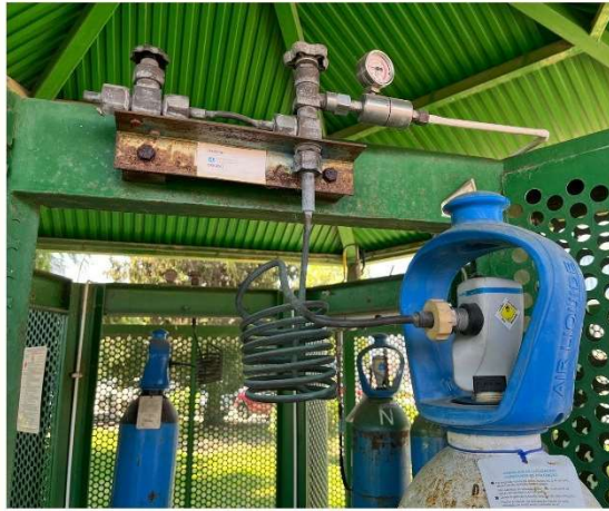
Cambio Colector Central Oxígeno
