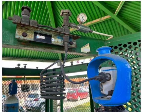
Cambio Colector Central Nitrógeno
