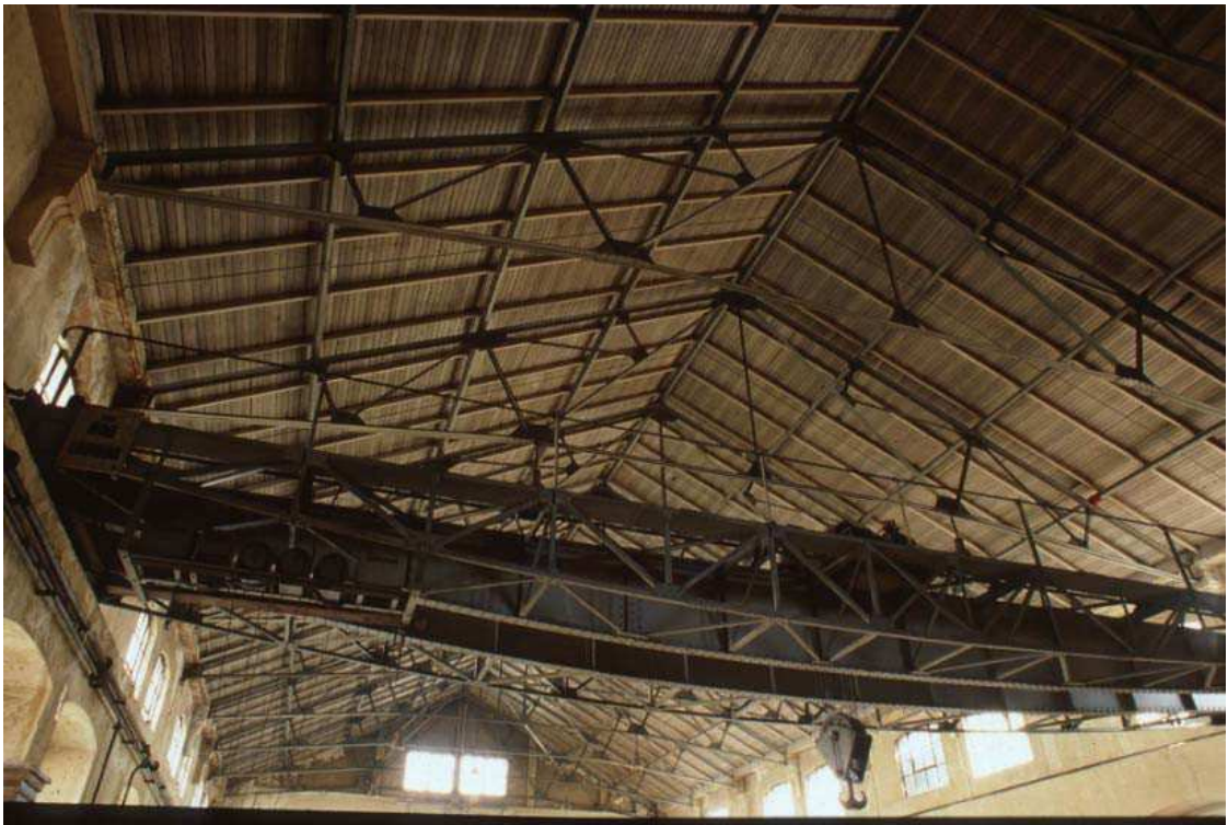
Vista del puente-grúa y de la cubierta originales
