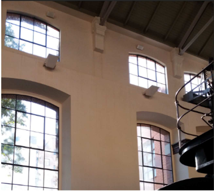
Bañadores de pared e iluminación de emergencia
